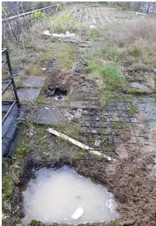
Slika 67 Prikaz zadržavanja vode na ploči terase [13]
