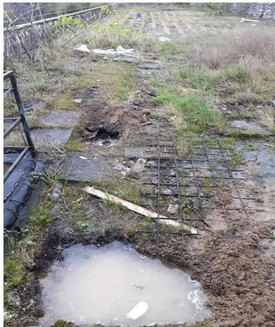
Slika 29 Ploča terase koja je pod stalnih utjecajem atmosferilija i na kojoj se zadržava voda koja utječe na armaturu ploče ali i na sami beton [13]
