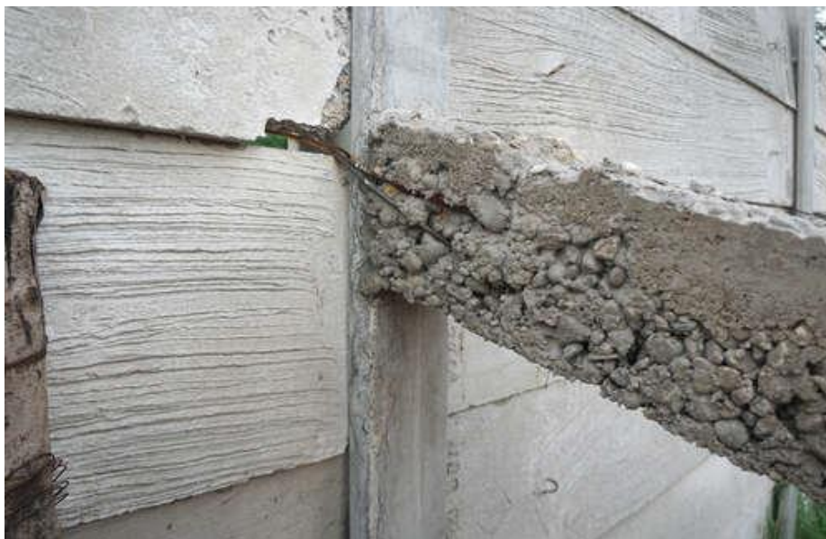
Slika 12 Segregacija betona [14]
