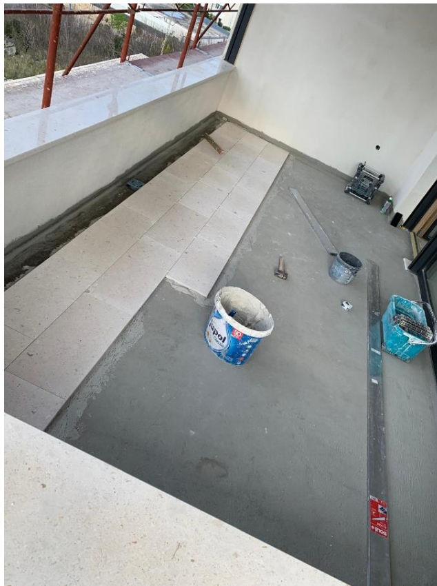
Slika 11: Ugradnja kamenih ploča (fotografirao autor)
