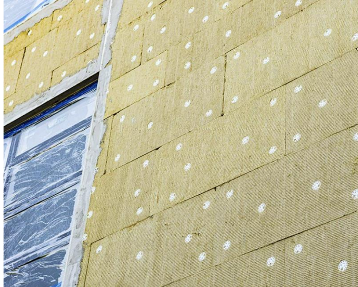
Slika 7: Ugrađene Rockwool ploče mineralne vune (fotografirao autor)
