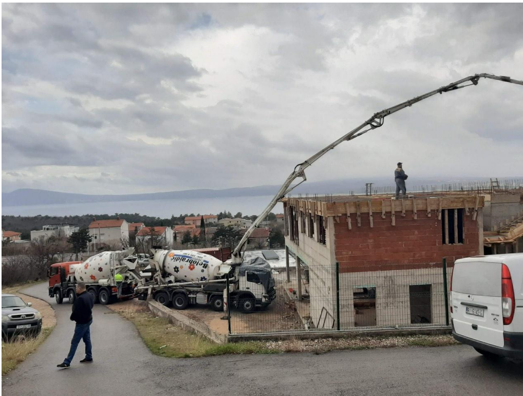
Slika 3: Ugradnja betona pumpom za beton (fotografirao autor)
