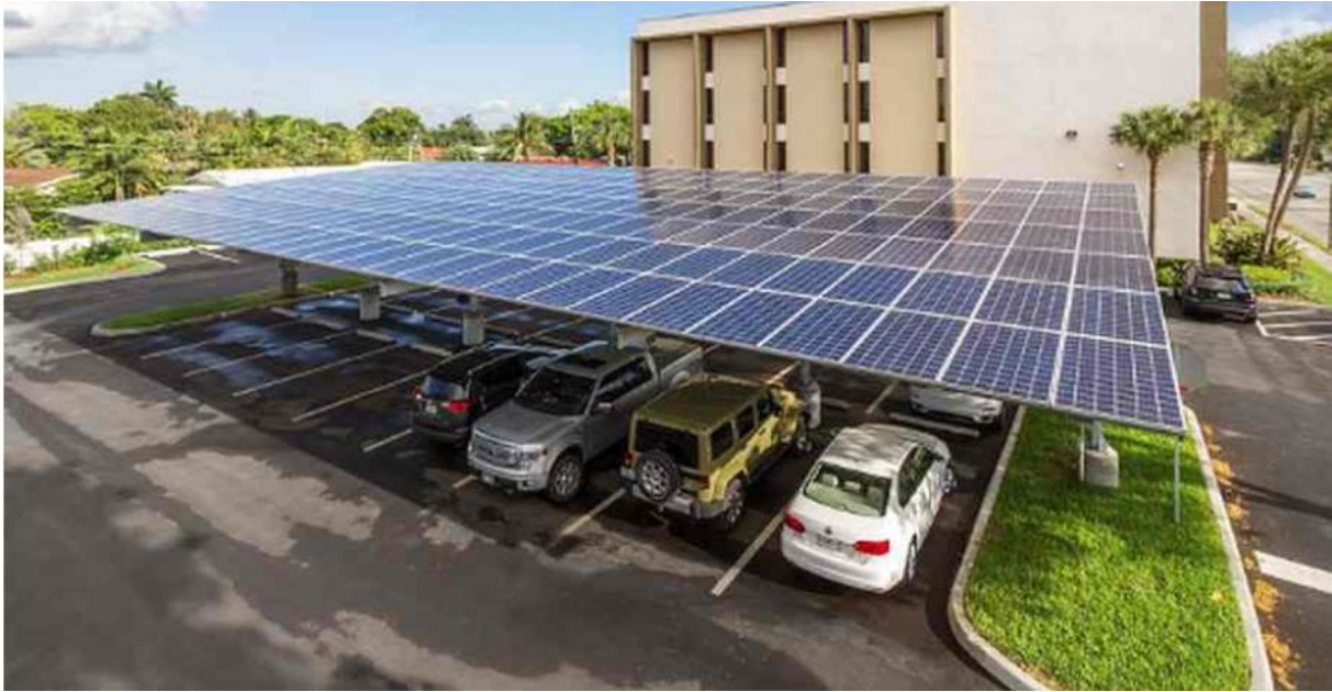
Slika 2: Solarni paneli kao pokrov nadstrešnice za auto [2]
