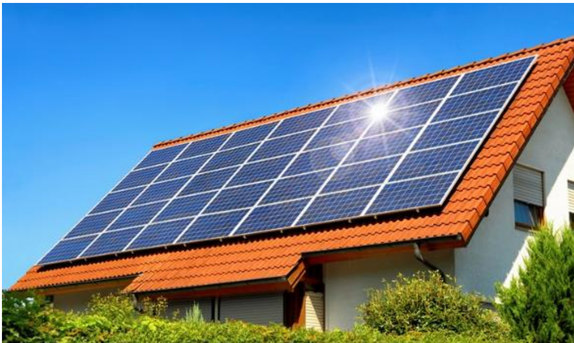
Slika 1: Solarni paneli na krovu [1]
