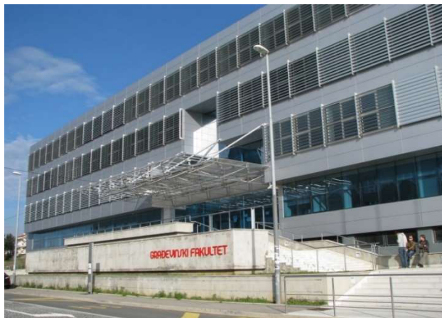
Slika 13: Zgrada građevinskog fakulteta u Rijeci [9]
