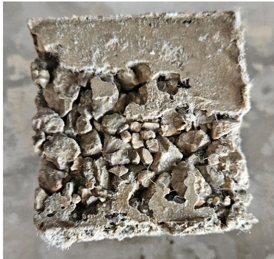
Slika 3.: Poroznost betonske mješavine (Autor: Nikolina Edjut)
