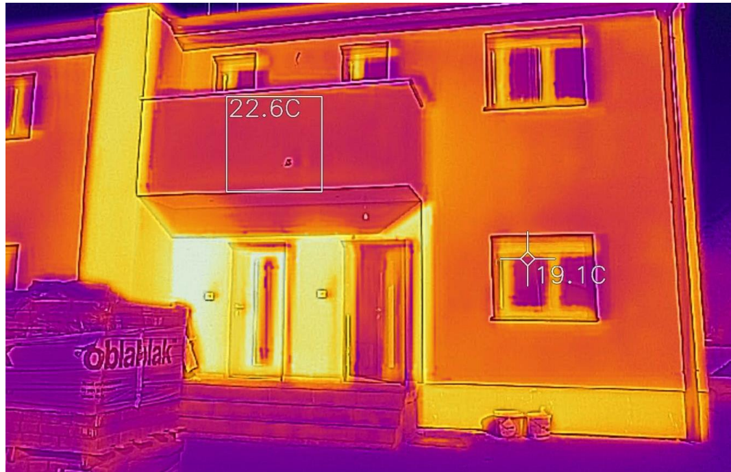
Slika 1: Termografski prikaz toplinskih gubitaka zgrade [27]
