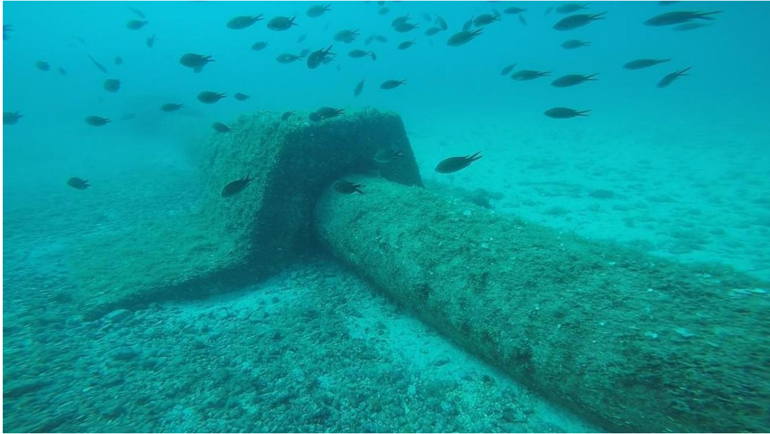
Slika 8 Prikaz cjevovoda podmorskog ispusta osiguranog betonskim opteživačem [15]
