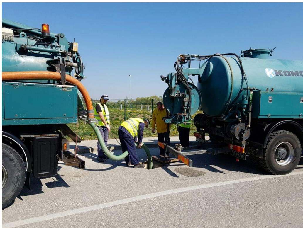
Slika 10 Prikaz čišćenja kanalizacije [17]
