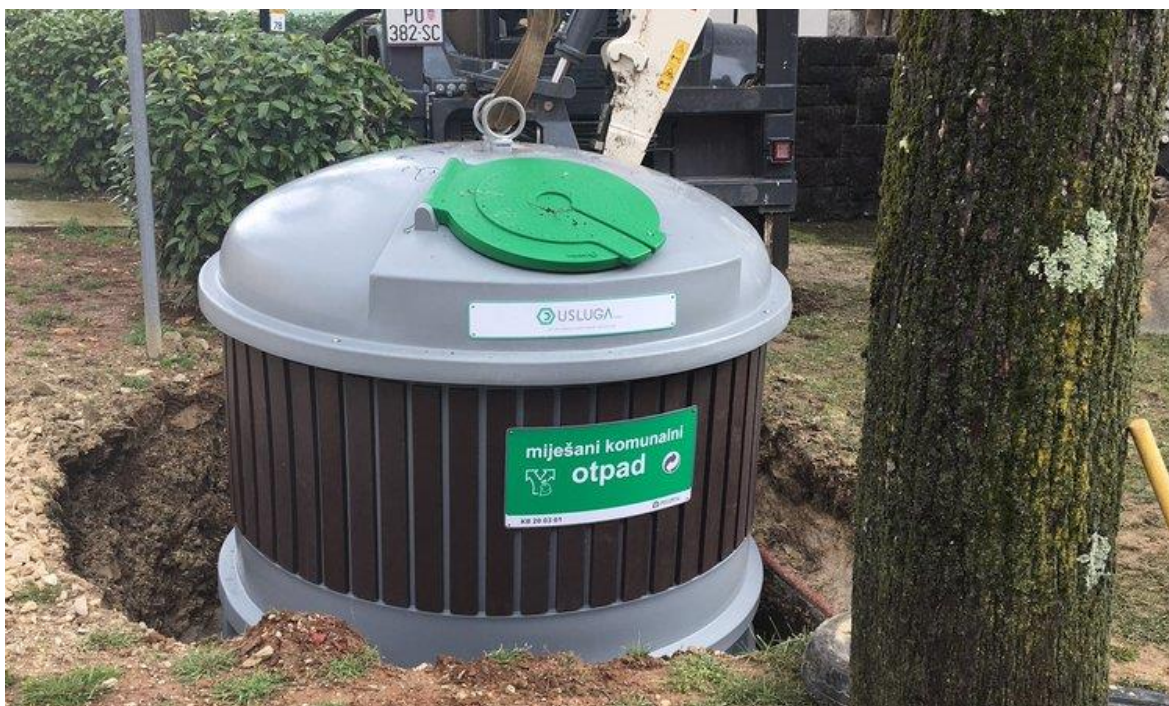
Slika 5. Polupodzemni spremnik za miješani komunalni otpad [15]
