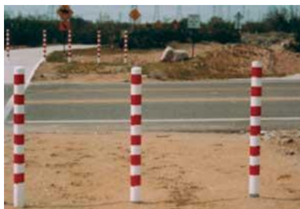
Slika 14: Prikaz postavljanja stupića na ulazu u stazu [18]
