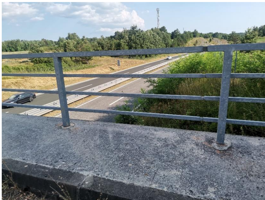
Slika 56: Metalna ograda na početku mosta
