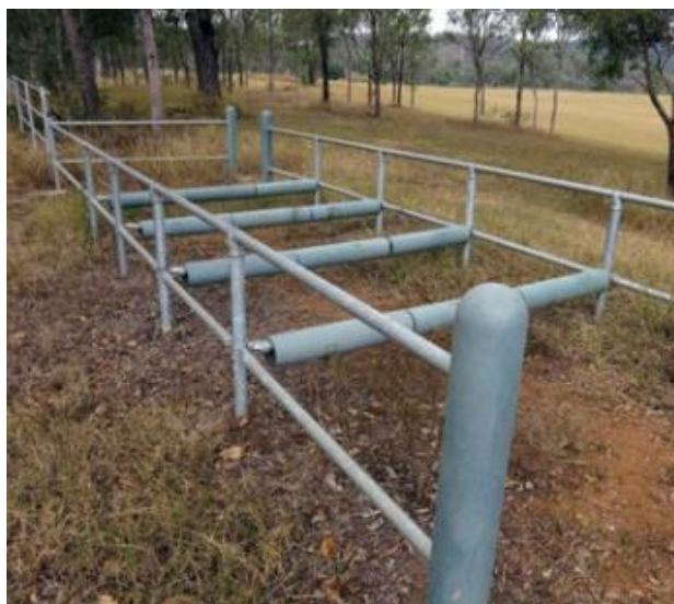
Slika 44: Prikaz metalnih prepreka za prelaženje obloženih gumom [10]
