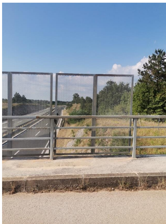
Slika 57: Metalna mreža na rasponu od 28 metara
