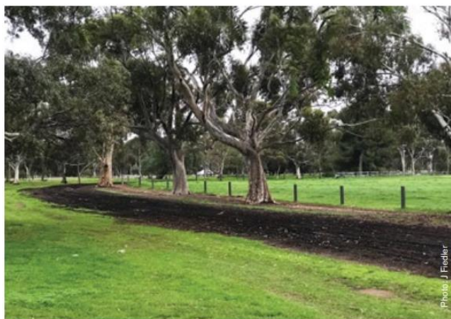
Slika 38: staza sa površinom od drvene sječke [10]
