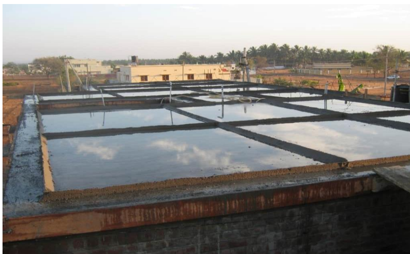
Slika 1. "Ponding" metoda [8]
