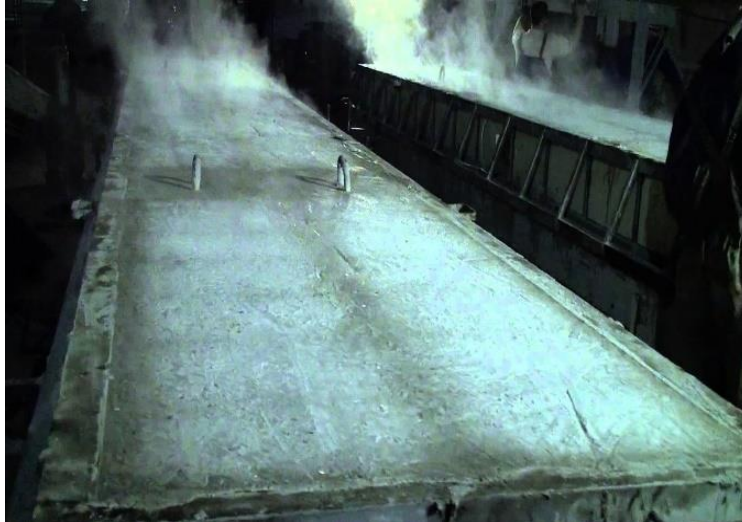
Slika 7. Njega betona zaparivanjem[16]
