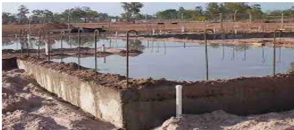
Slika 5. Njega betona pokrivanjem slojem zemlje [13]
