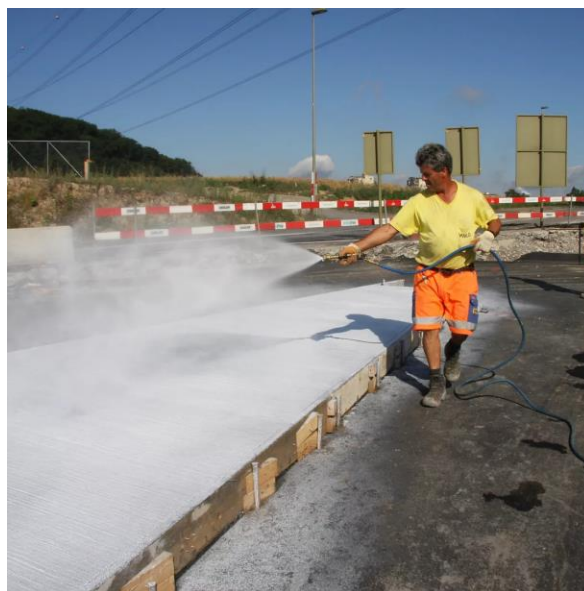
Slika 2. Vlaženje betona prskanjem [9]
