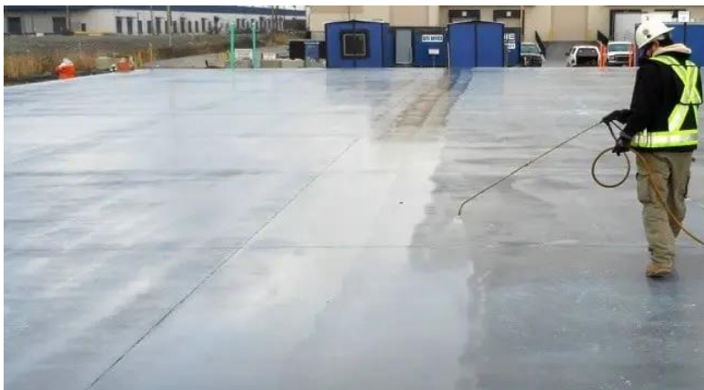
Slika 4. Njega betona tekućom membranom[12]
