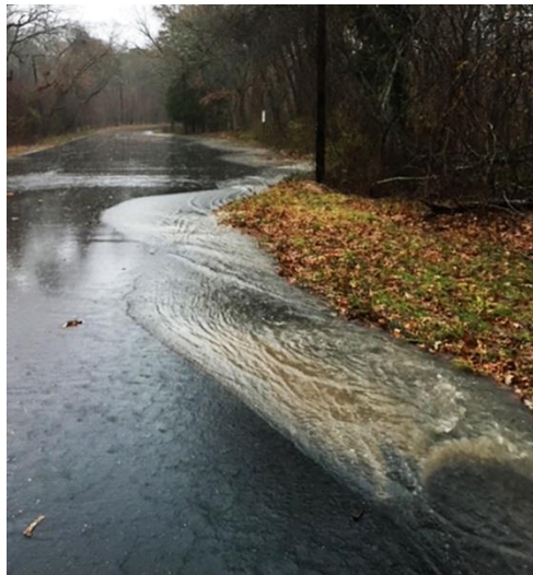
Slika 2. Otjecanje oborinskih voda sa asfaltirane prometnice [15]
