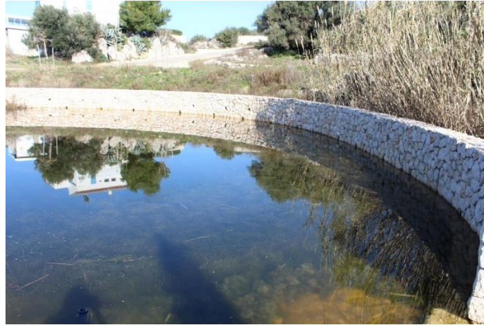
Slika 23. Zaštitni zid na lokvi Škuncini stani
