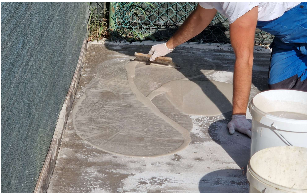
Slika 9: Prikaz izlivanja smole nakon miješanja te njeno apliciranje. (Autor: Anton Bekić)
