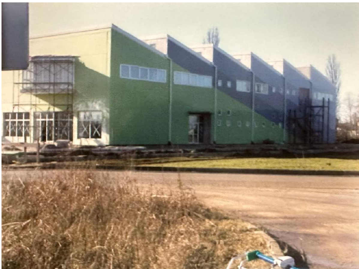
Slika 11: Prikaz ugrađenog akrilnog premaza[10]
