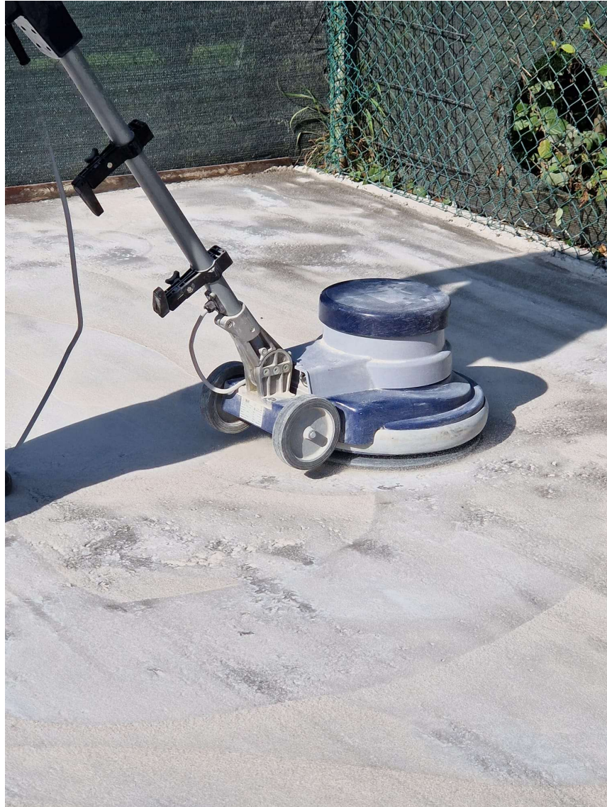
Slika 5: Prikaz mehaničkog čišćenja betonske površine velikom dijamantnom brusilicom(Autor: Anton Bekić)
