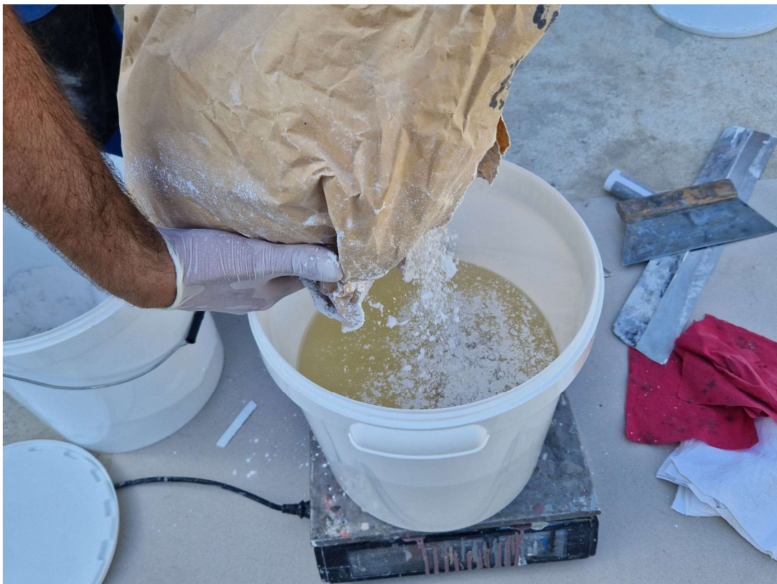
Slika 7: Prikaz miješanja poliuretanskog premaza A i B komponente nakon točnog mjerenja njihovog omjera. (Autor: Anton Bekić)
