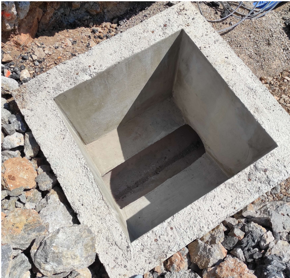
Slika 27: Obradena kineta i zidovi armirano-betonskog okna (autor, 2024)
