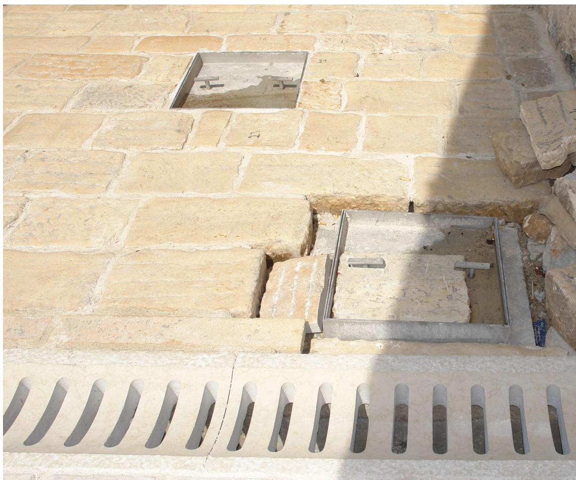
Slika 49: Uklapanje poklopca u kameni raster ulice (autor, 2008)
