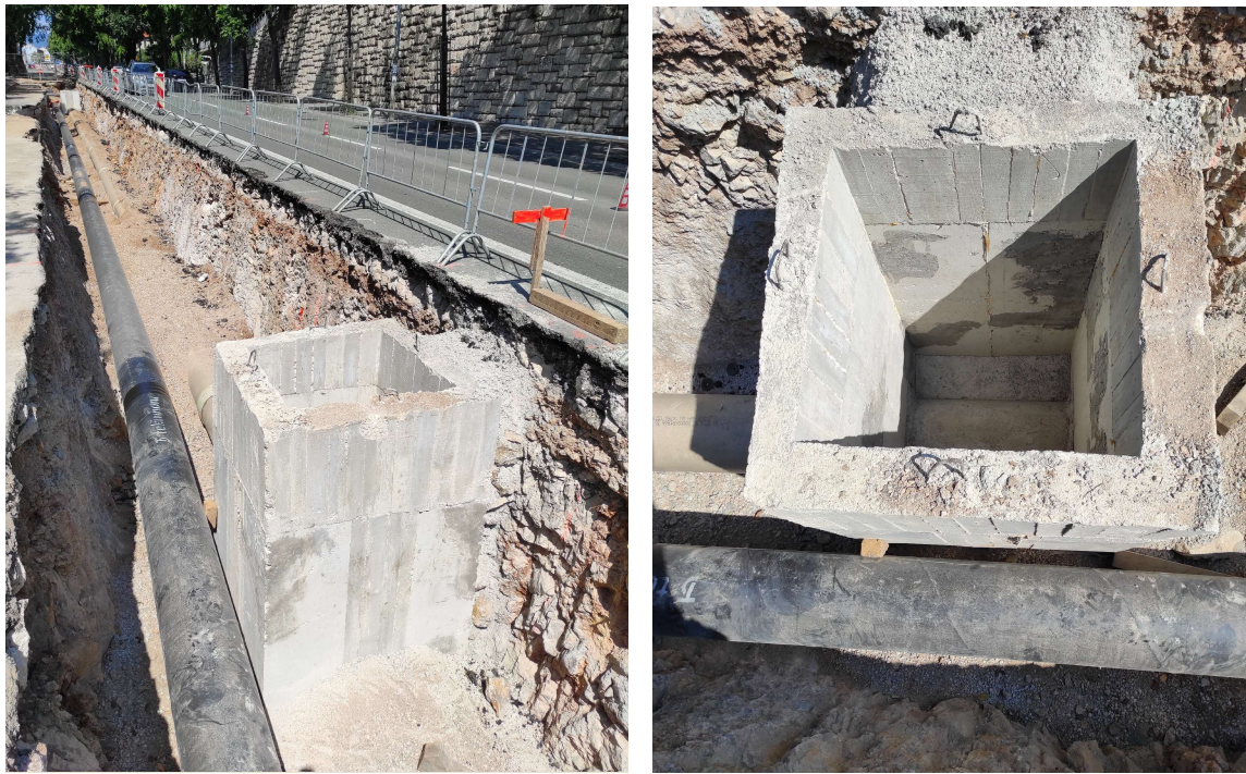
Slika 26: Izvedena armirano-betonska okna (autor, 2024)
