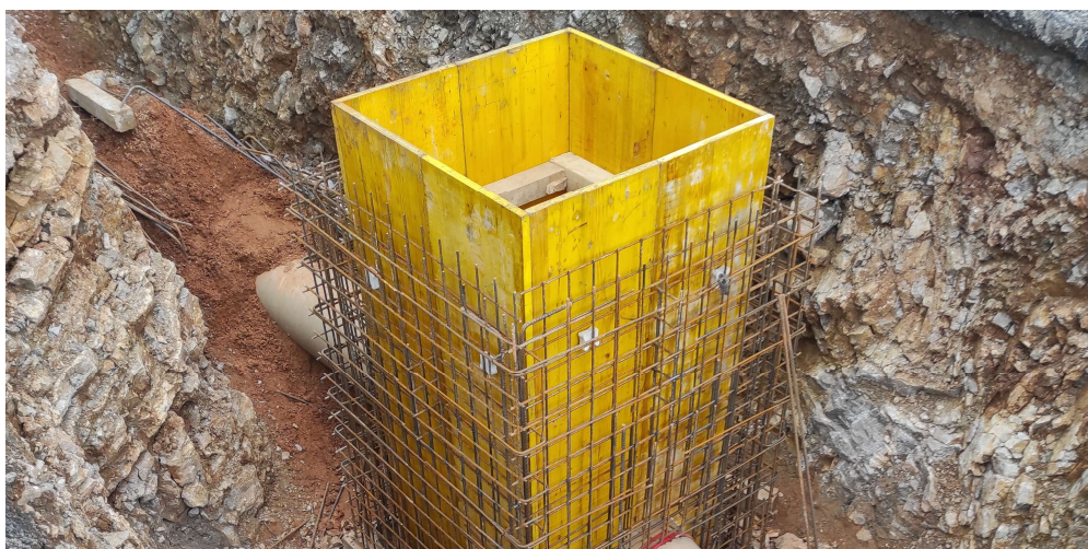
Slika 18: Primjer okna monolitne izvedbe (autor, 2023)
