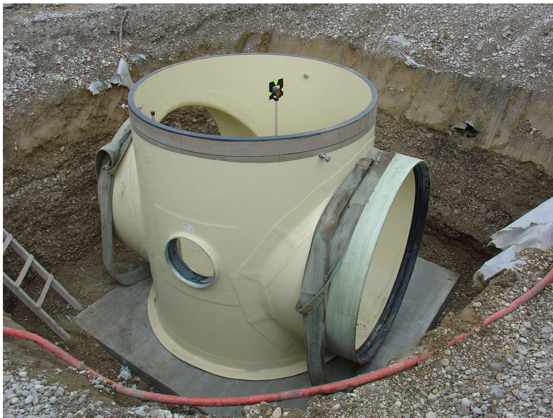
Slika 32: Primjer ugradnje predgotovljenog GRP okna [15]
