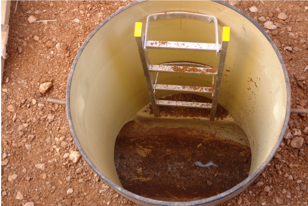
Slika 6: Primjer ljestvi ugrađenih u GRP oknu (autor, 2007)
