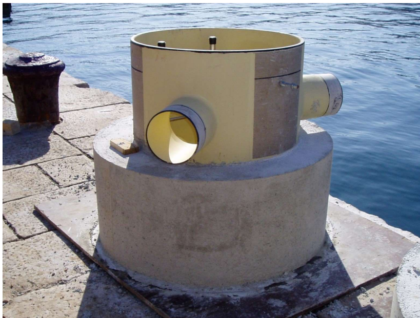
Slika 42: Primjer kružnog betonskog opteživača izvedenog na „kopnu“ [15]
