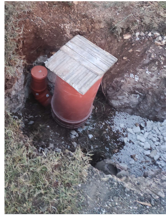
Slika 35: Detalj priključnog PVC okna DN 400 mm (autor, 2023)
