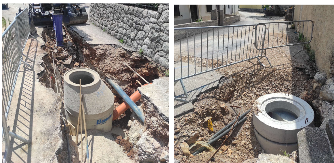
Slika 30: Primjer ugradnje predgotovljenog betonskog okna (autor, 2024)
