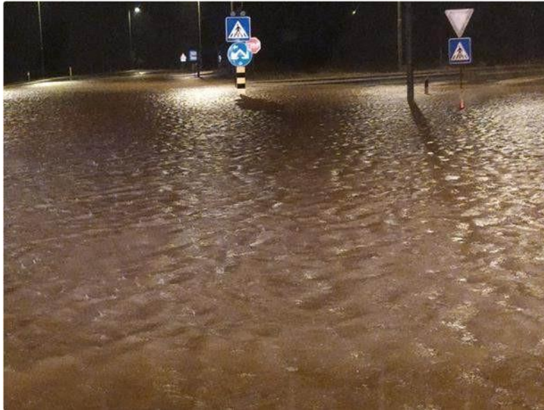
Slika 8. Poplavljena cesta kod Stancije Vodopije [9]
