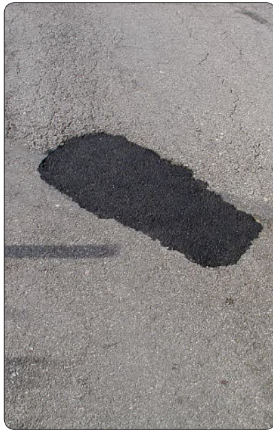
Slika 2.2.2. Udarna rupa, zakrpa, S2
