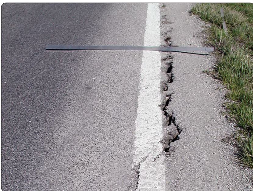
Slika 3.7.3. Slijevanje ruba kolnika, S3
