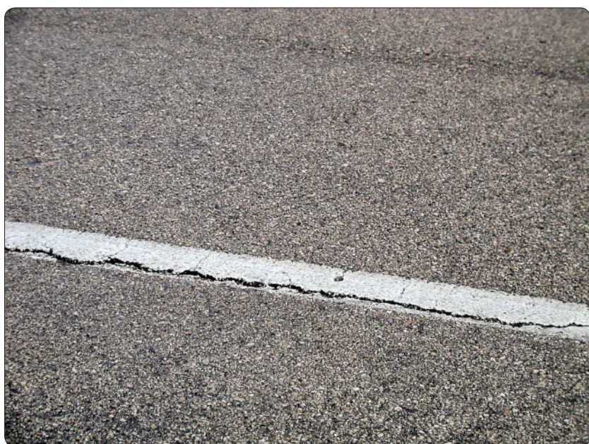
Slika 4.5.2. Otvoreni radni spoj, S2
