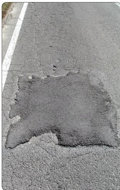
Slika 2.2.3. Udarna rupa, zakrpa, S3
