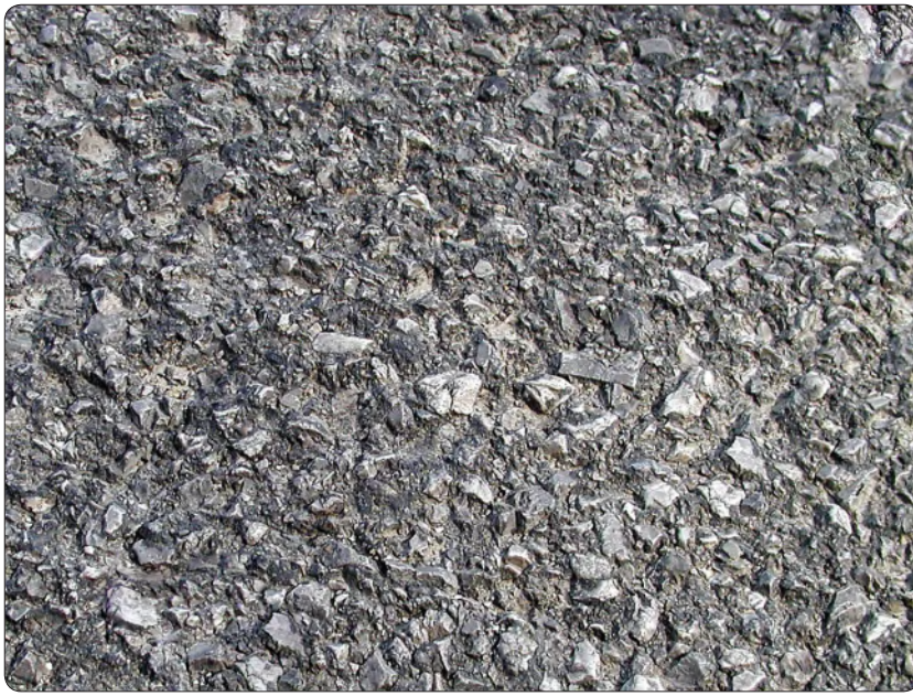
Slika 1.3.1. Trošenje, S1
