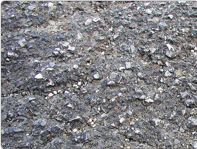
Slika 1.3.2. Trošenje, S2
