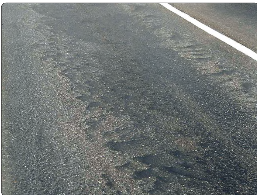
Slika 1.2.3. Jako izbijanje bitumenskog veziva, S3
