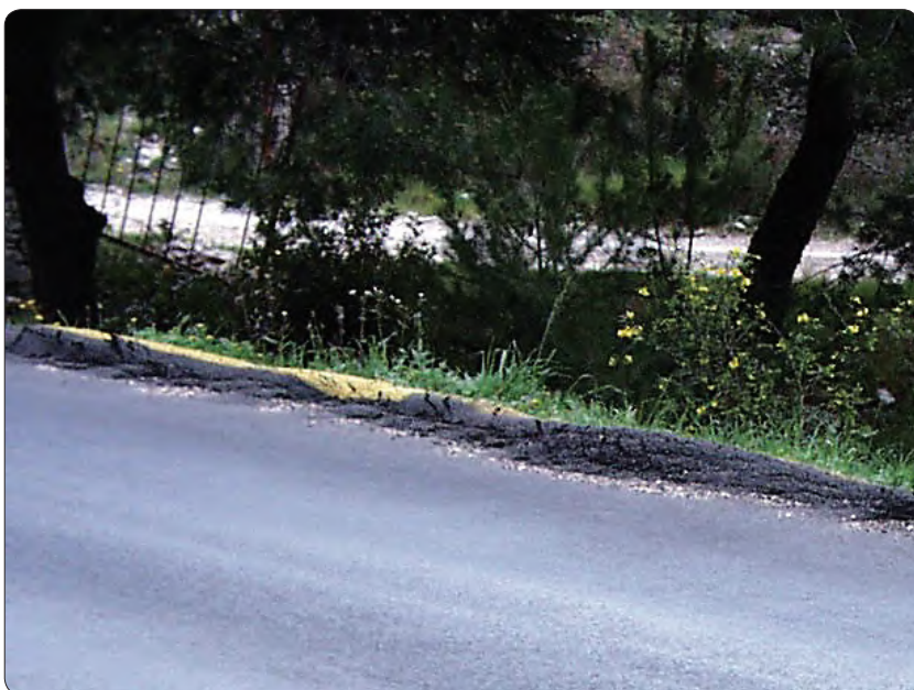
Slika 3.5.2. Bočno istiskivanje, S2
