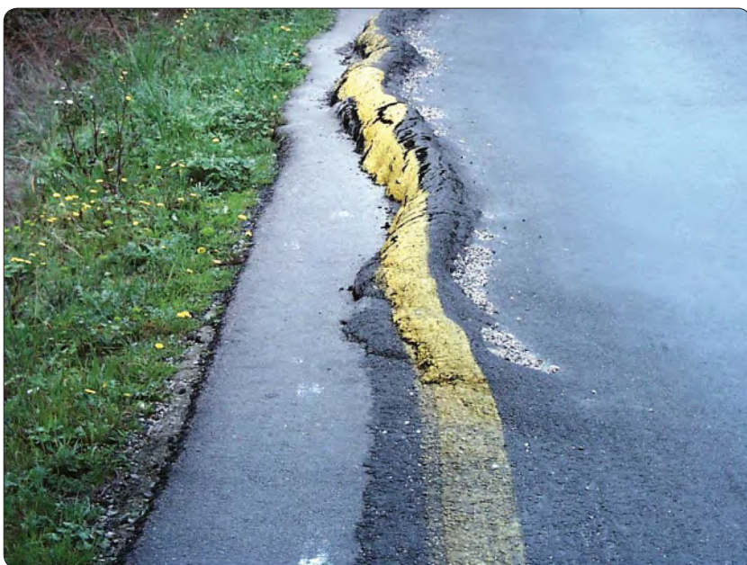
Slika 3.5.3. Bočno istiskivanje, S3
