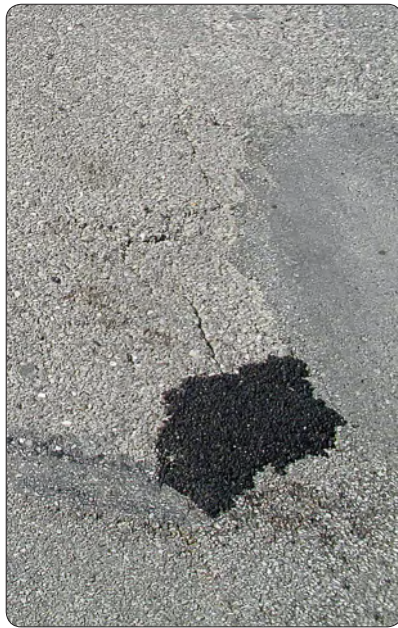
Slika 2.2.1. Udarna rupa, zakrpa, S1
