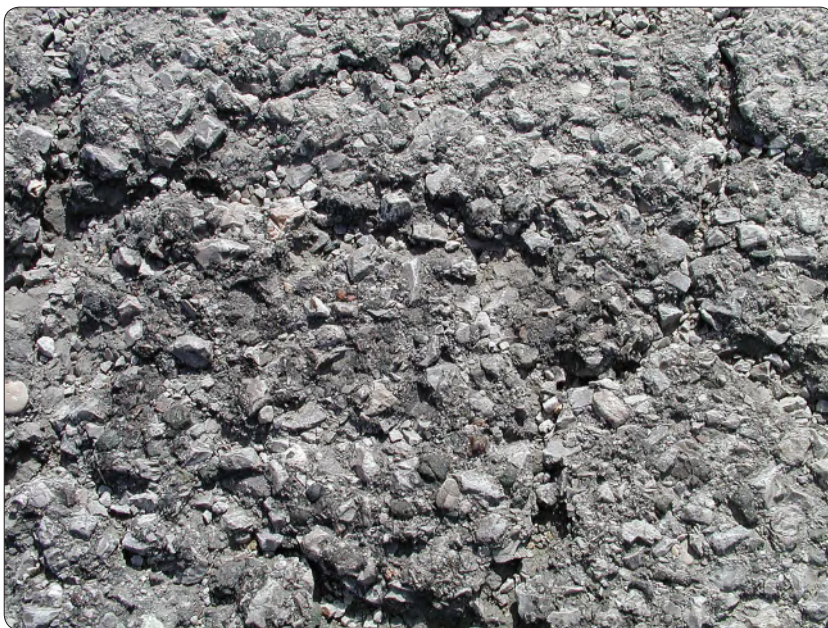
Slika 1.3.3. Trošenje, S3
