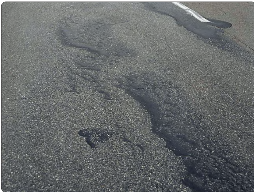
Slika 1.2.2. Izbijanje bitumenskog veziva u tragu kotača, S2
