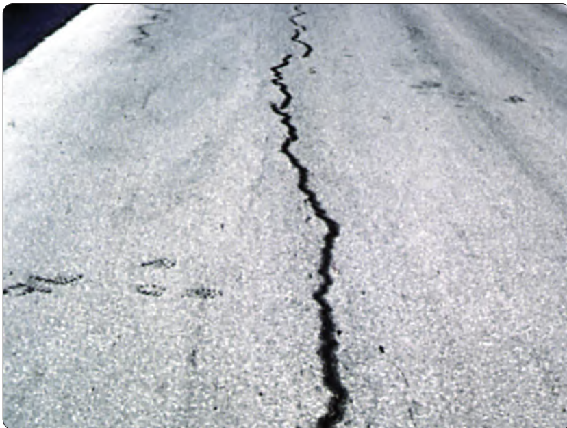
Slika 3.8.2. Izdizanje kolnika uslijed smrzavanja, S3
