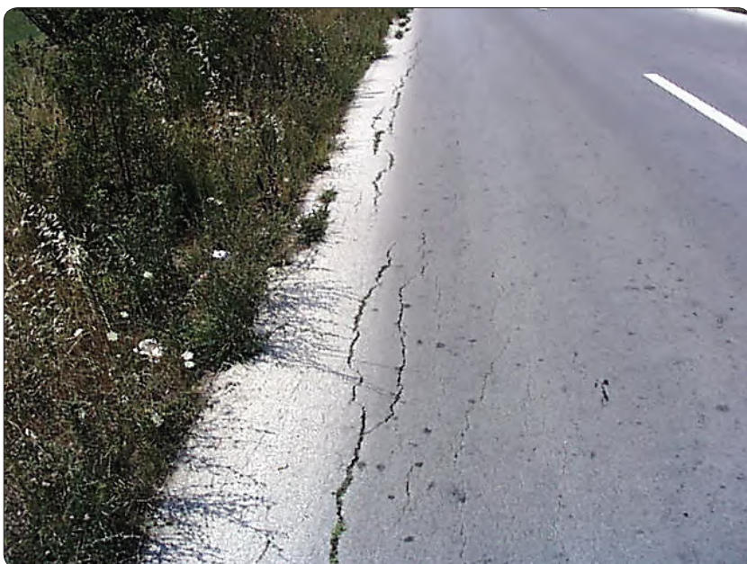
Slika 3.7.2. Slijevanje ruba kolnika, S2
