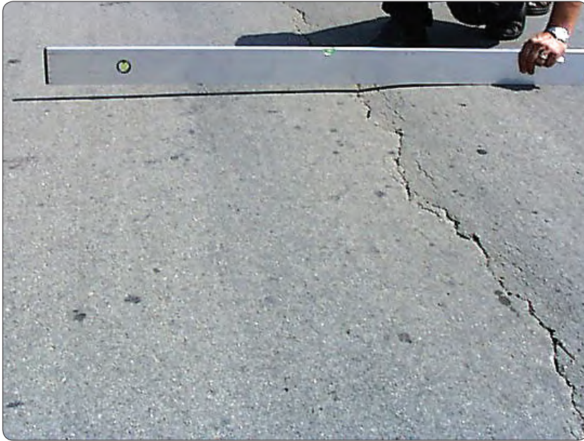
Slika 3.8.1. Izdizanje kolnika uslijed smrzavanja, S2
