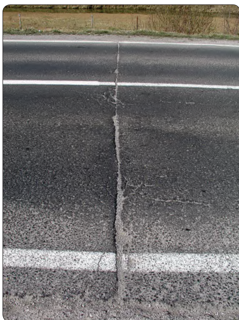
Slika 4.5.3. Otvoreni poprečni radni spoj, S3
