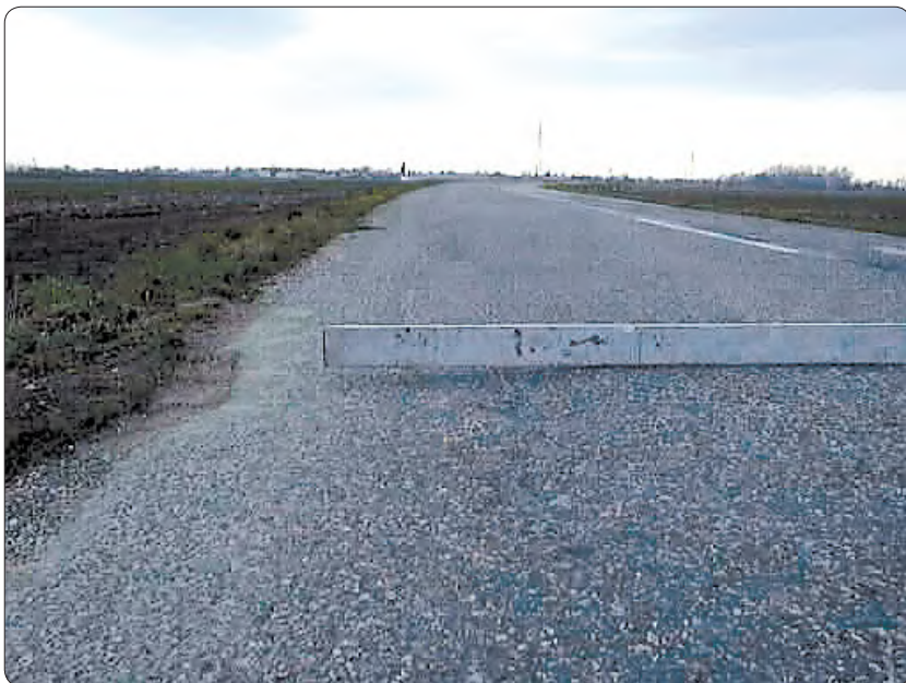
Slika 3.7.1. Slijevanje ruba kolnika, S1
