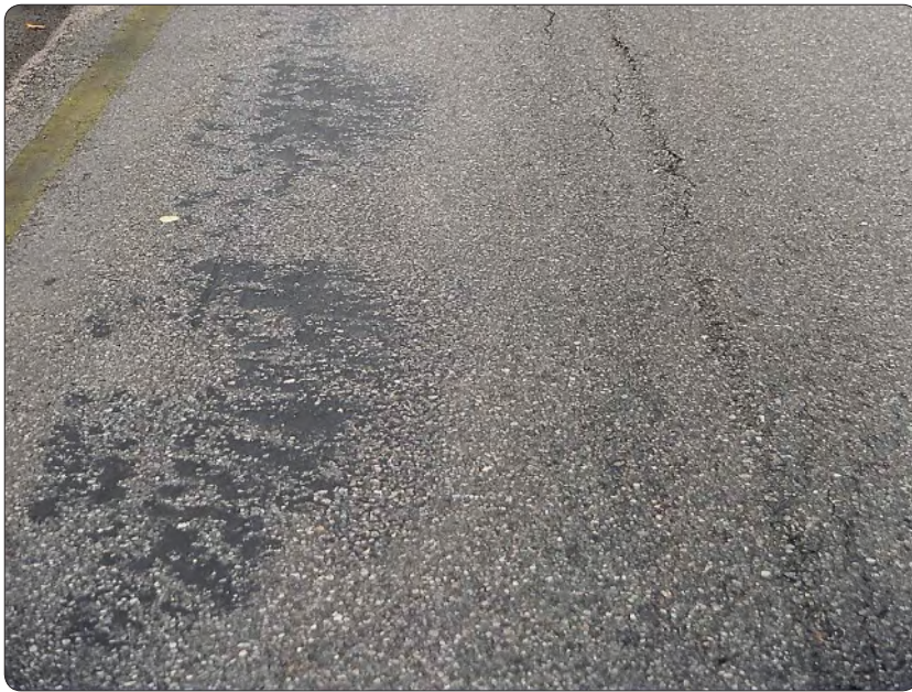
Slika 1.2.1. Izbijanje bitumenskog veziva u tragu kotača, S1
