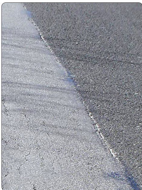
Slika 4.5.1. Otvoreni radni spoj, S1
