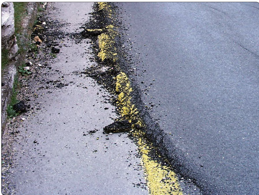
Slika 3.5.1. Bočno istiskivanje, S1
