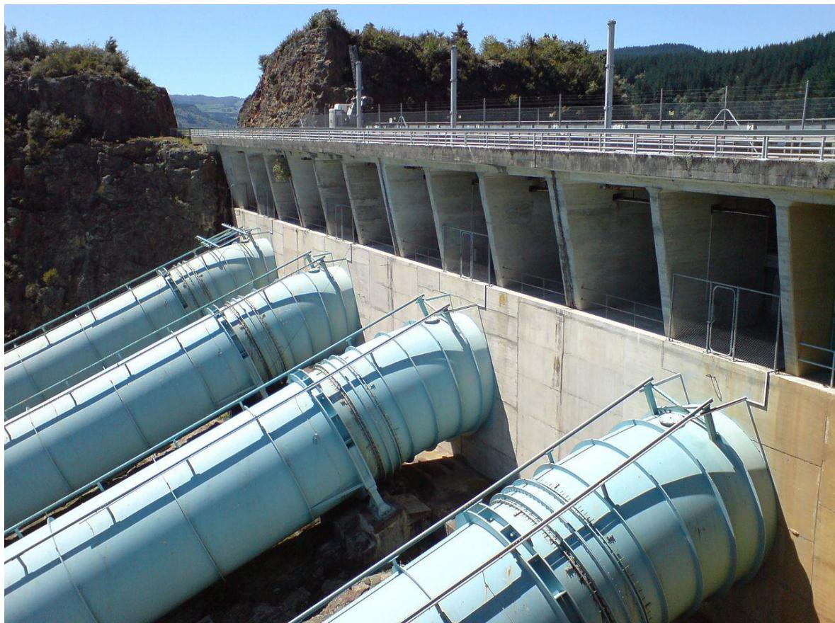
Slika 11: Tlačni cjevovod [4]
