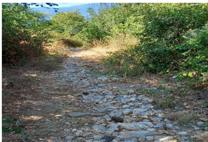
Slika 75: Pristup mostu neuređenom obraslom stazom [autorica]
