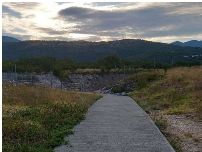
Slika 98: Betonska pristupna staza [autorica]
