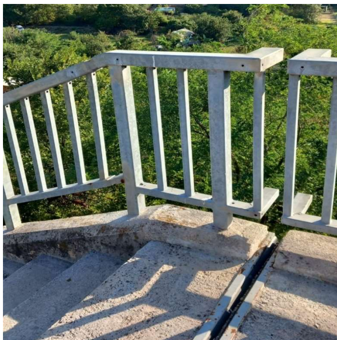
Slika 94: Prekid ograde i rukohvata [autorica]
