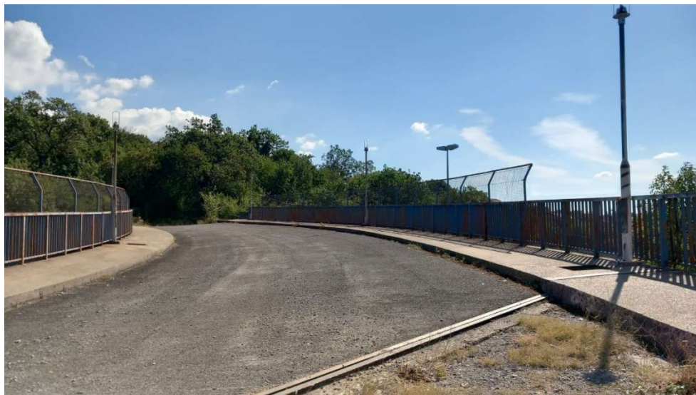
Slika 74: Hodna ploha i ograde na mostu [autorica]
