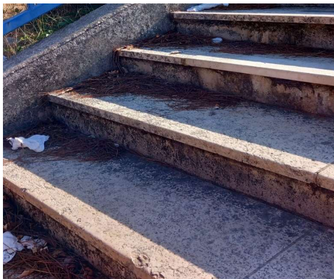
Slika 87: Detalj obloge stuba kamenim pločama [autorica]
