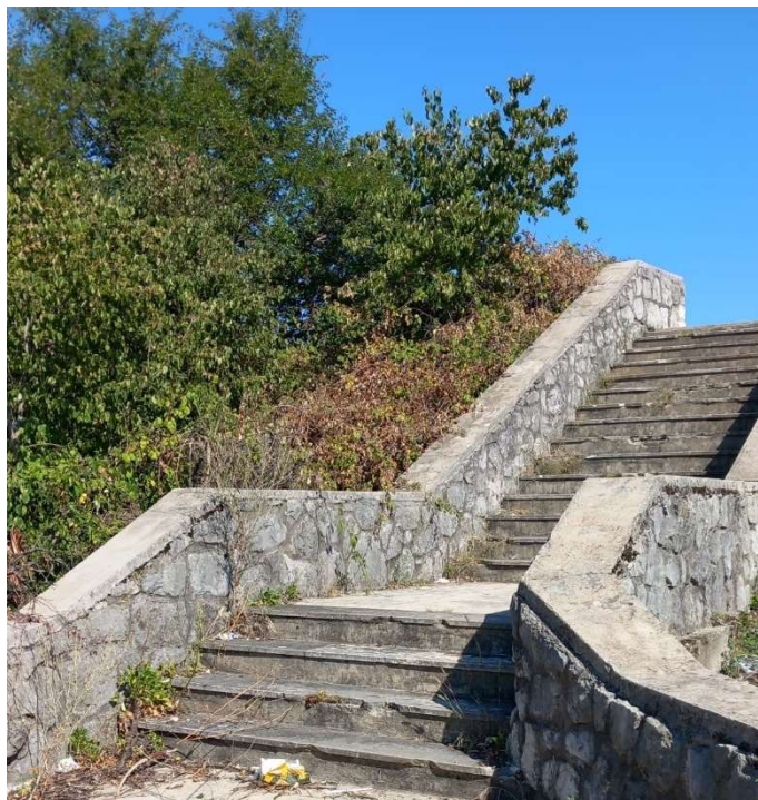
Slika 76: Stubište sa zidićem [autorica]
