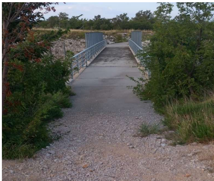
Slika 97: Pristup mostu od strane Krasice [autorica]
