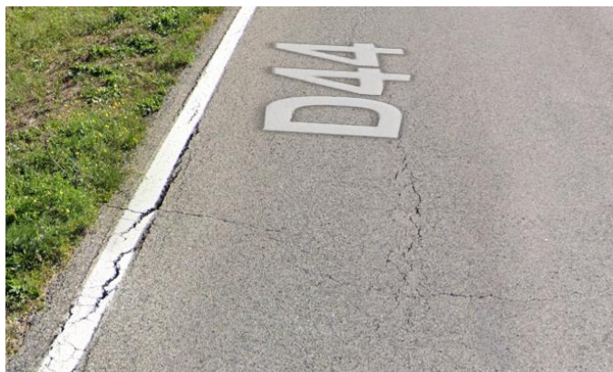
Slika 23. Deformacije na rubu kolnika [Google karte]
