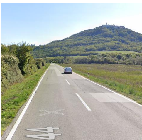
Slika 21. Sanirani segmenti kolnika[Google karte]
