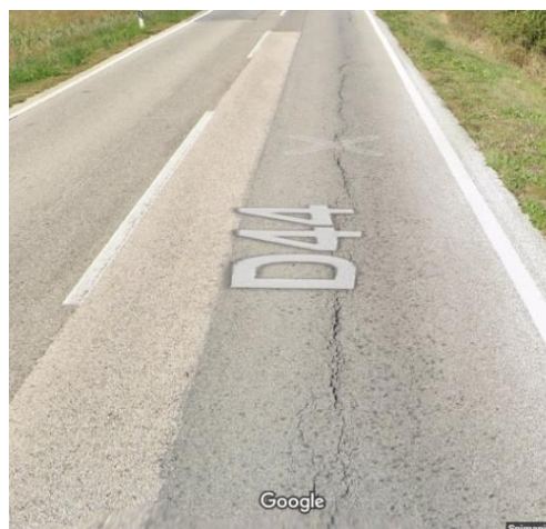
Slika 22. Deformacije na kolniku[Google karte]
