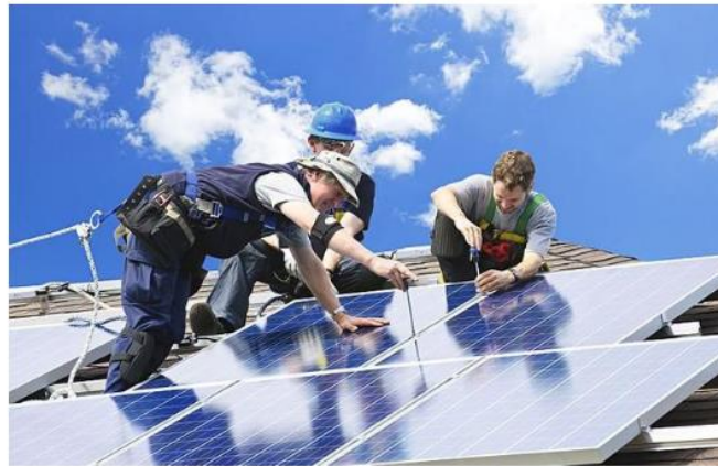
Slika 1: Ugradnja solarnih panela na krov konstrukcije [3]
