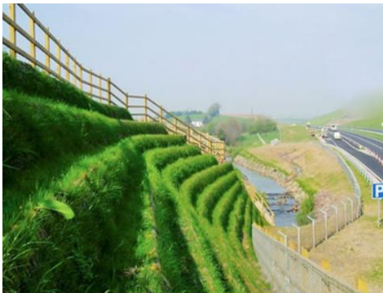
Slika 15. Gabionski zid ozelenjen vegetacijom [13]
