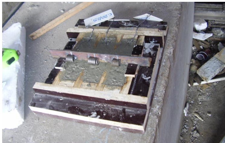
Slika 3.7 Betoniranje kalupa za eksperiment čupanja pojedinačnog vlakna iz betonske prizme
