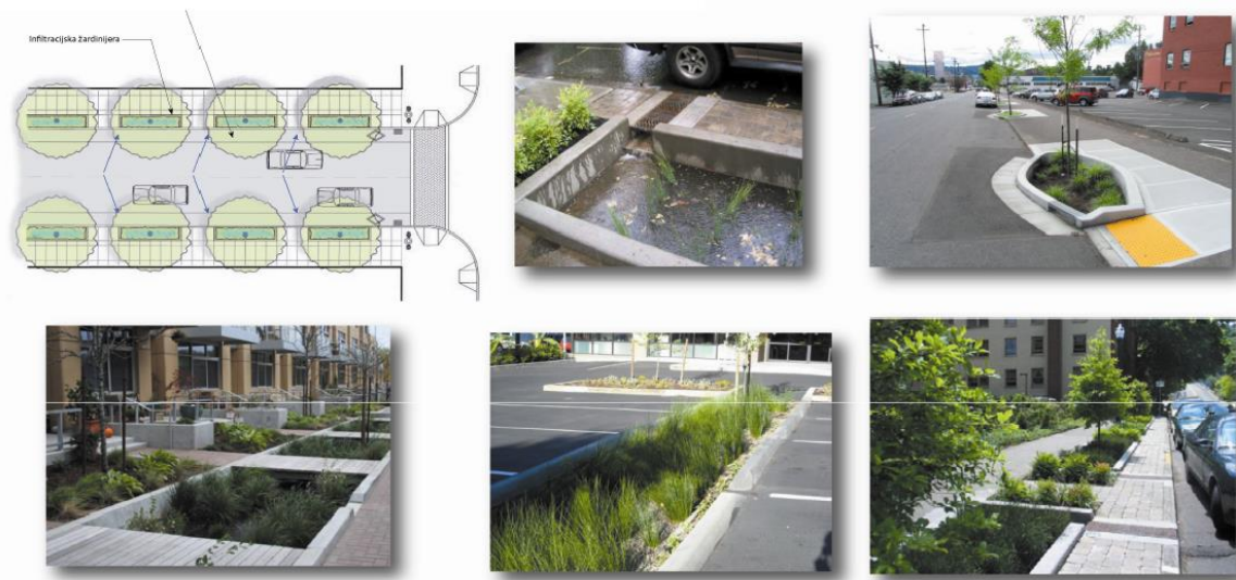
Slika 15. Mogućnosti odvodnje ulica i parkinga [12]
