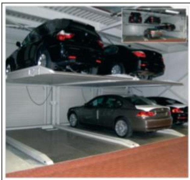
Slika br.17: Djelomično mehanizirana parking garaža Brčić, Šošćarić, 2012., str. 82
