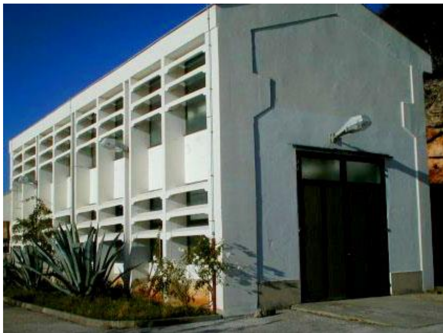
Slika 8. Pumpna stanica, crpilište vode Vrana, otok Cres ( www.viocl.hr )
