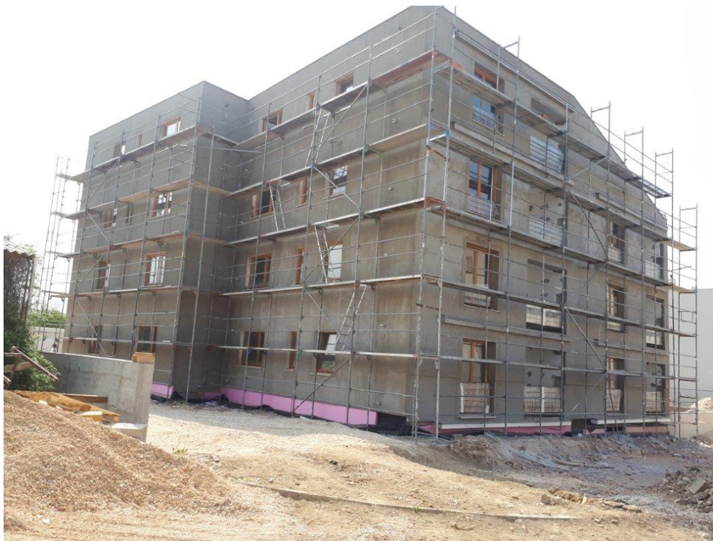
Slika 17: Sjeverozapadno pročelje za vrijeme građenja
