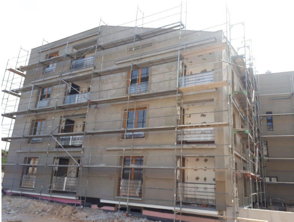
Slika 16: Sjeveroistočno pročelje za vrijeme građenja
