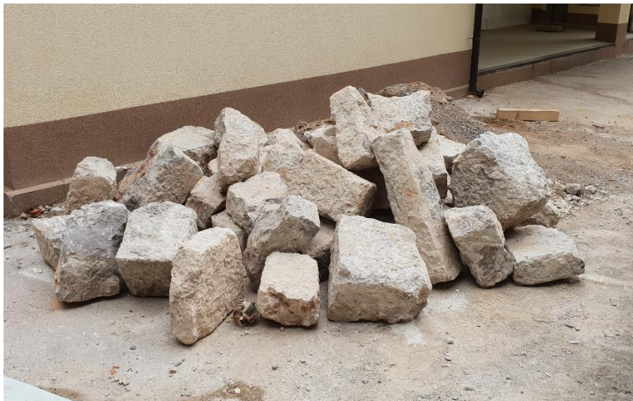
Slika 25: Veličina kamenih blokova izvađenih iz postojećih zidova na poziciji izrade novih otvora [ Izvor: autor ]
