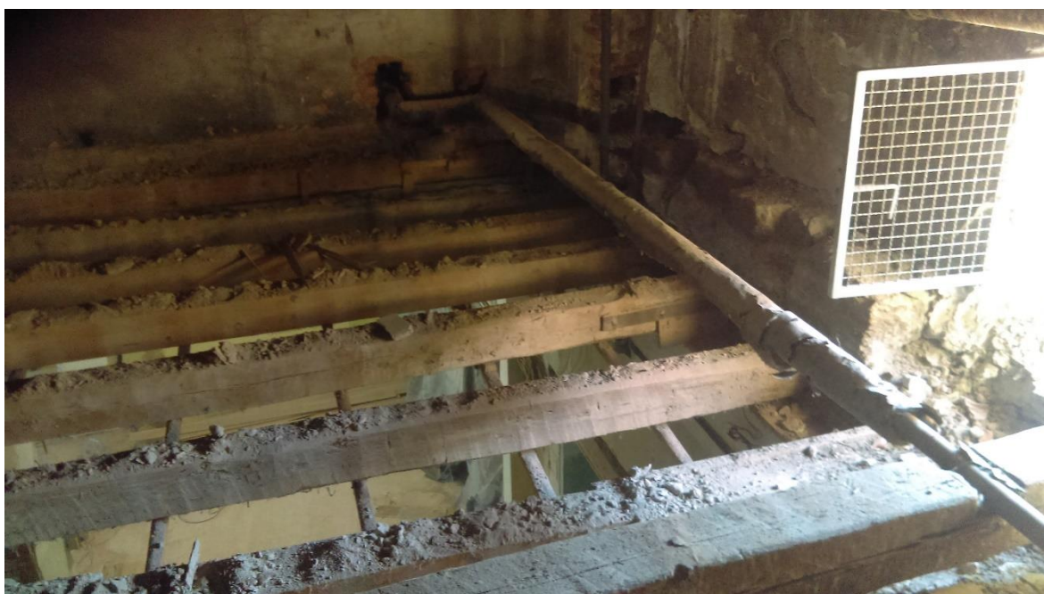
Slika 27: Postojeće grede međukatne konstrukcije [ Izvor: autor]
