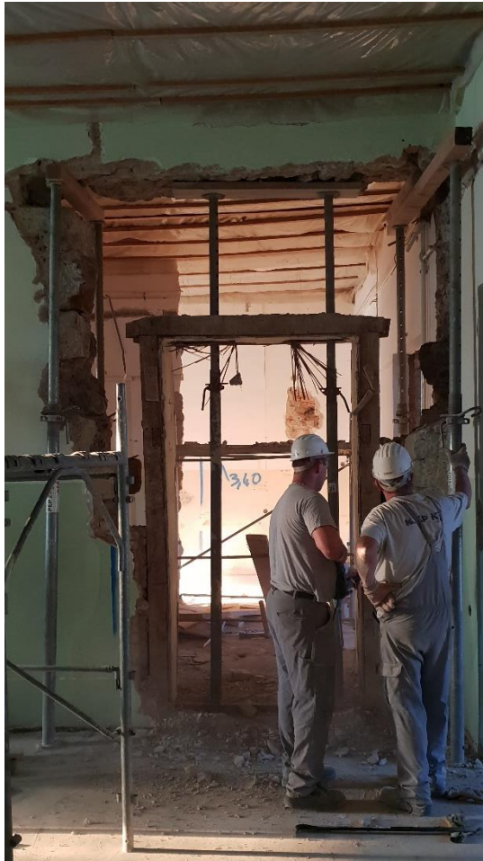
Slika 26: Izrada otvora u nosivom kamenom zidu [ Izvor: autor ]
