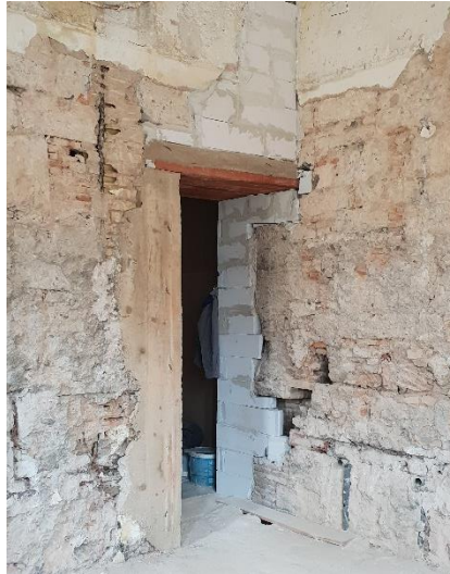
Slika 8: Izvedeni prodor s predgotovljenim elementom kao nadvoj [ Izvor: autor ]
