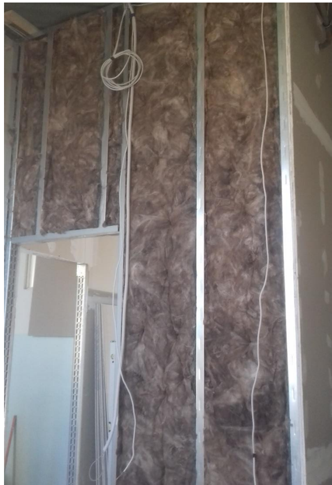
Slika 17: Postavljanje izolacije kamene vune između profila gipskartonskog zida [ Izvor: autor ]
