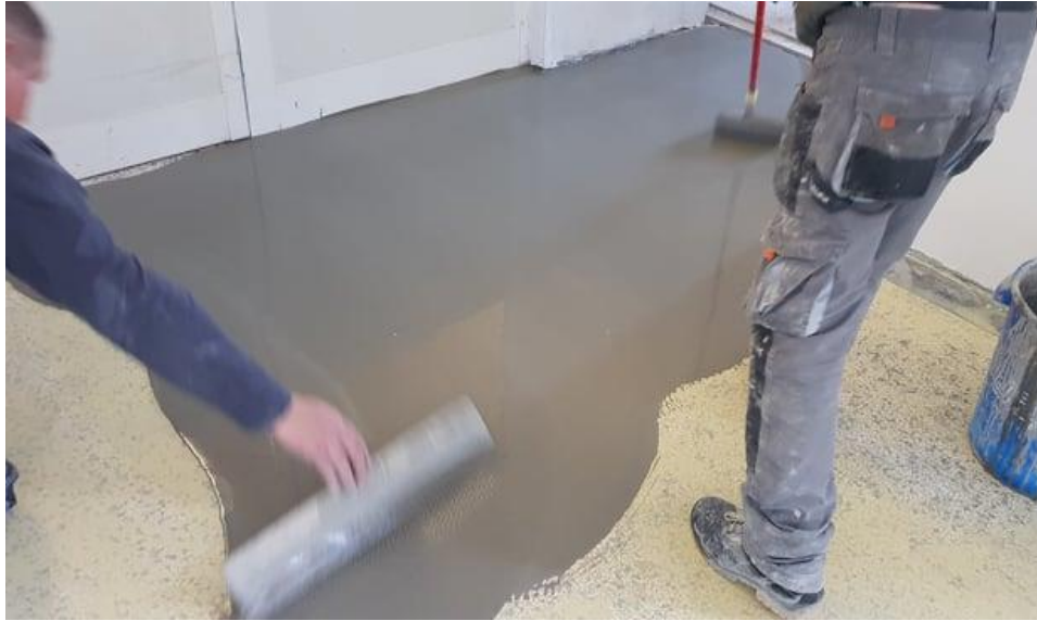
Slika 34: Ugradnja nivelirajuće mase kao podloga za izradu linoleuma kao završni sloj [ Izvor: autor ]
