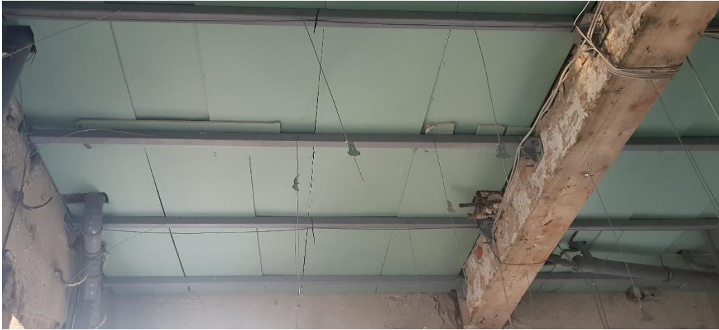
Slika 15: Izvedba čeličnog ojačanja učvršćena na postojeći zid te novu AB gredu s zaštitnim slojem vlagootpornih gipskartonskih ploča [ Izvor: Autor ]
