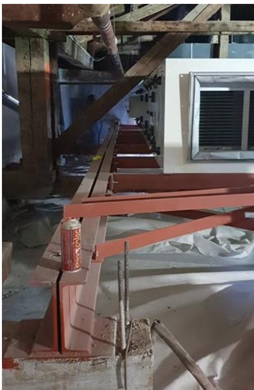
Slika 43: Čelični nosač na betonskom postolju [Izvor: autor]
