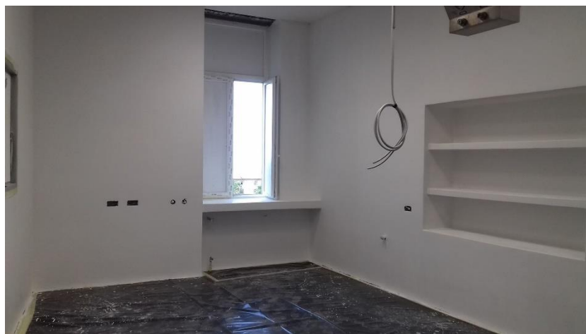
Slika 41: Dovršeni svi slojevi zidova, no još je potrebno ugraditi elemente u zidove te očistiti prostor [Izvor: autor]
