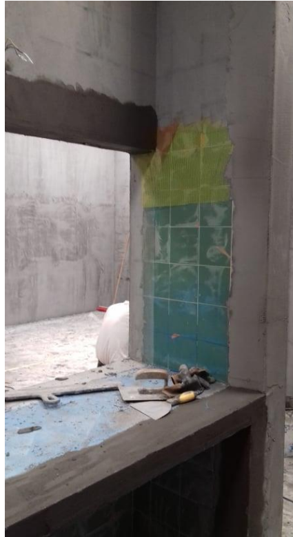
Slika 39: Zid operacijske sale gdje se vide temeljni premaz, 2 sloja ljepila te građevinska mrežica u sloju ljepila [Izvor: autor]
