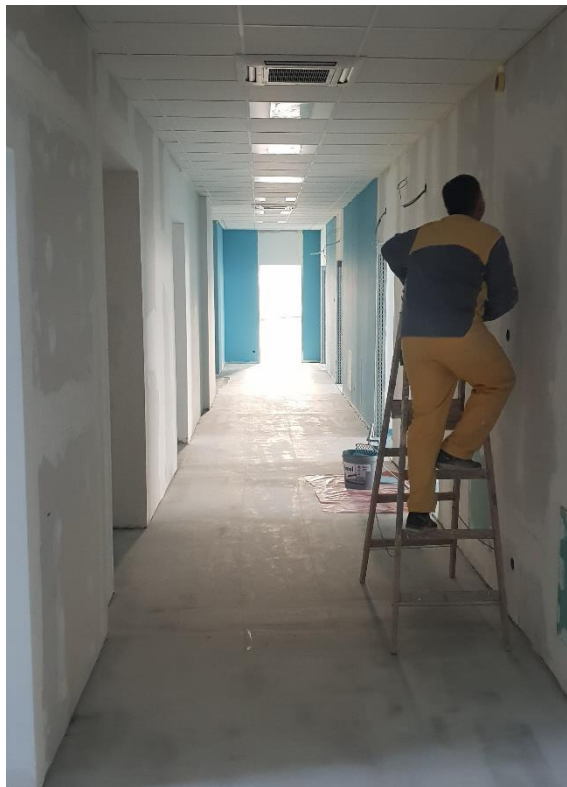
Slika 21: Knauf zidovi s izgletanim spojevima te spremni za bojanje [ Izvor: autor ]
