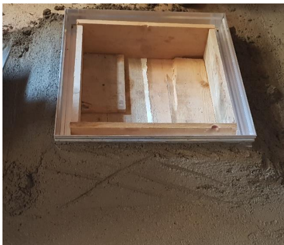
Slika 18: Šahta prizemlja u izradi poklopca [ Izvor: autor]
