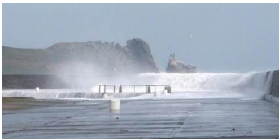
Slika 24: Mirno prelijevanje [1]
