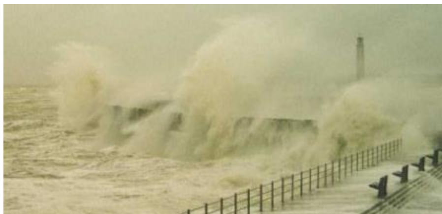
Slika 25: Nejednoliko, prskajuće prelijevanje [1]
