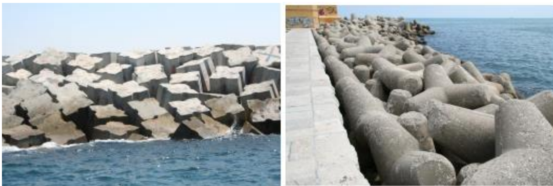
Slika 9: Lukobran obložen antiferima (lijevo) i tetrapodima (desno) [1]
