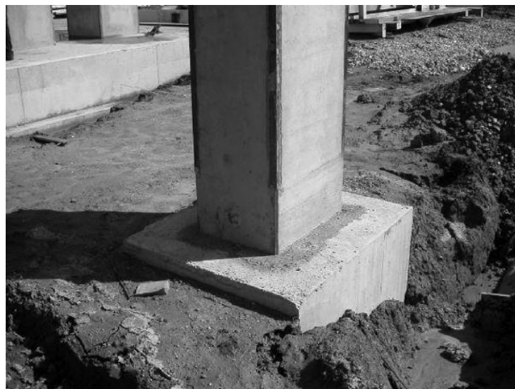
Slika 6: Spoj stup-temelj izveden pomoću temeljne čašice [2]
