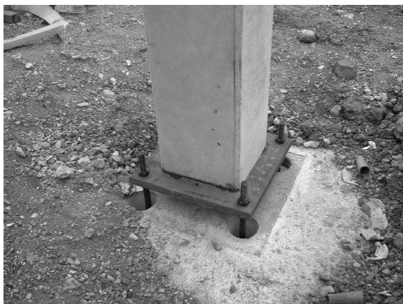
Slika 14: Spoj stup temelj s proširenom podložnom pločom [2]
