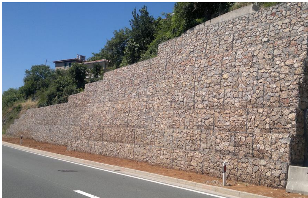
Slika 1. Gabionski zid uz prometnicu [2]
