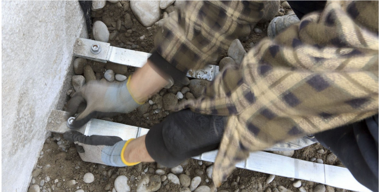
Slika 73. Postavljanje metalne armature ( http://www.trulinecivil.com )
