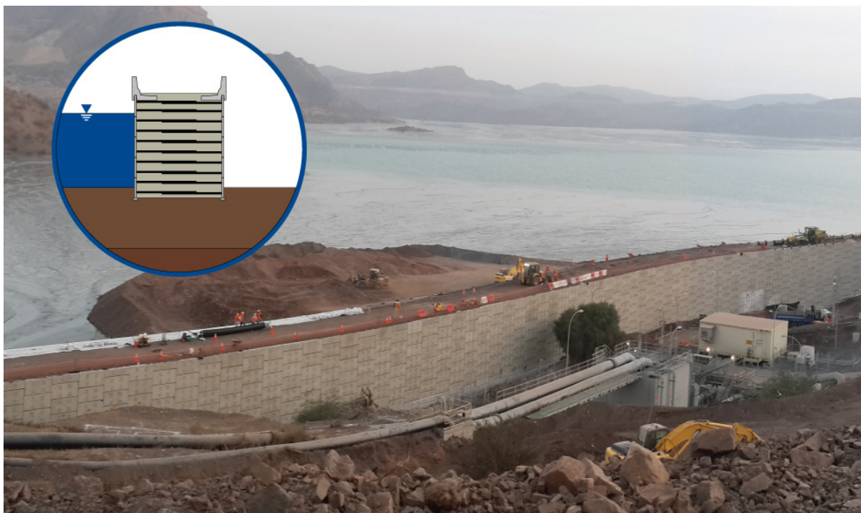
Slika 19. Zemljana brana sa dva lica ( https://reinforcedearth.com )
