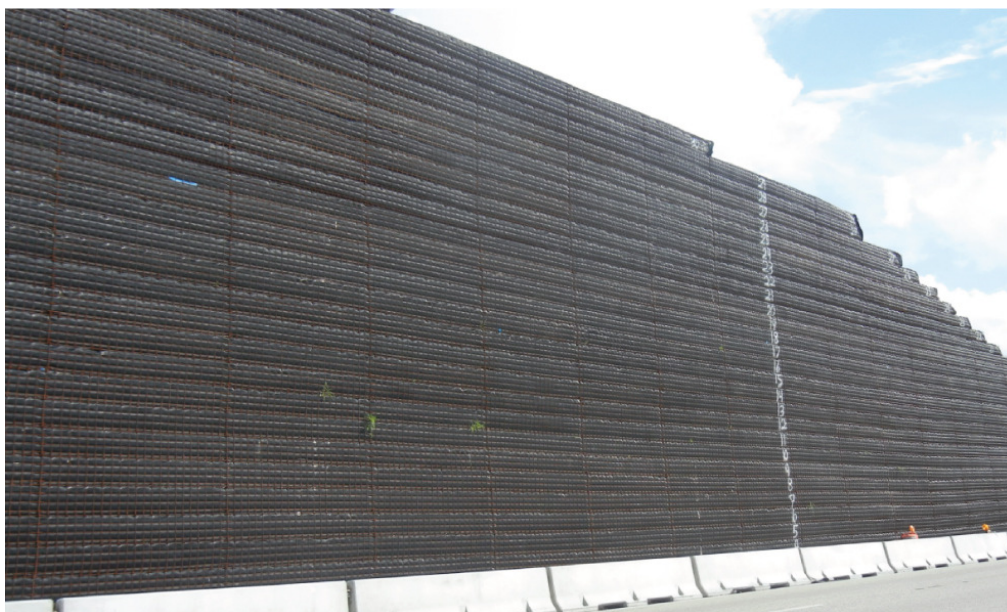
Slika 56. Lice zida od žičane mreže ( https://reinforcedearth.com )
