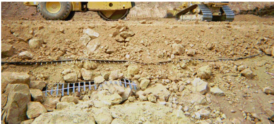
Slika 47. Armirano tlo bez lica (Roje-Bonacci, 2005.)
