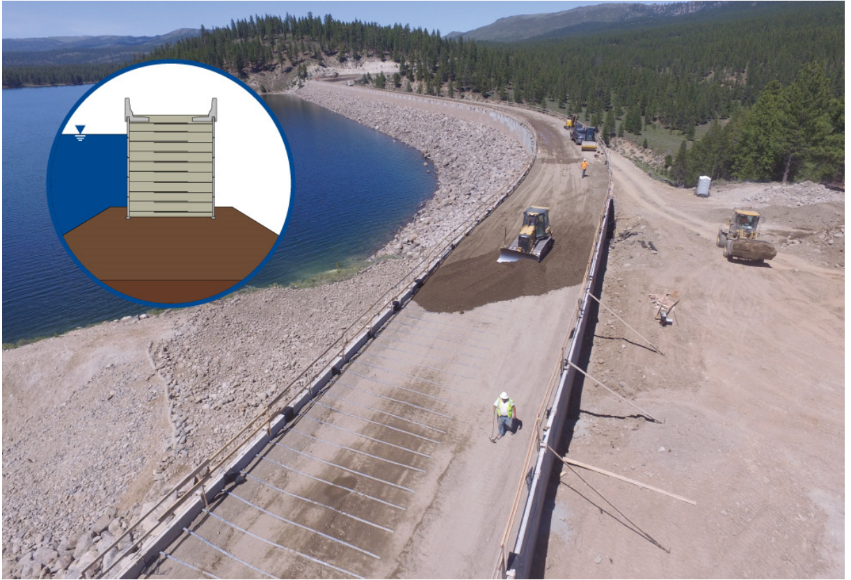
Slika 15. Podizanje vrha nasipa brane ( https://reinforcedearth.com )
