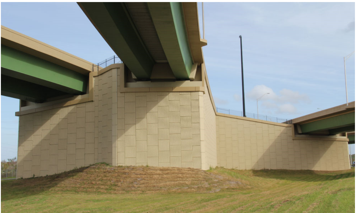
Slika 8. Upornjak mosta ( https://reinforcedearth.com )
