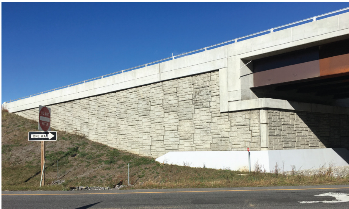
Slika 2. Primjer mehanički stabiliziranog zemljanog zida ( https://reinforcedearth.com )
