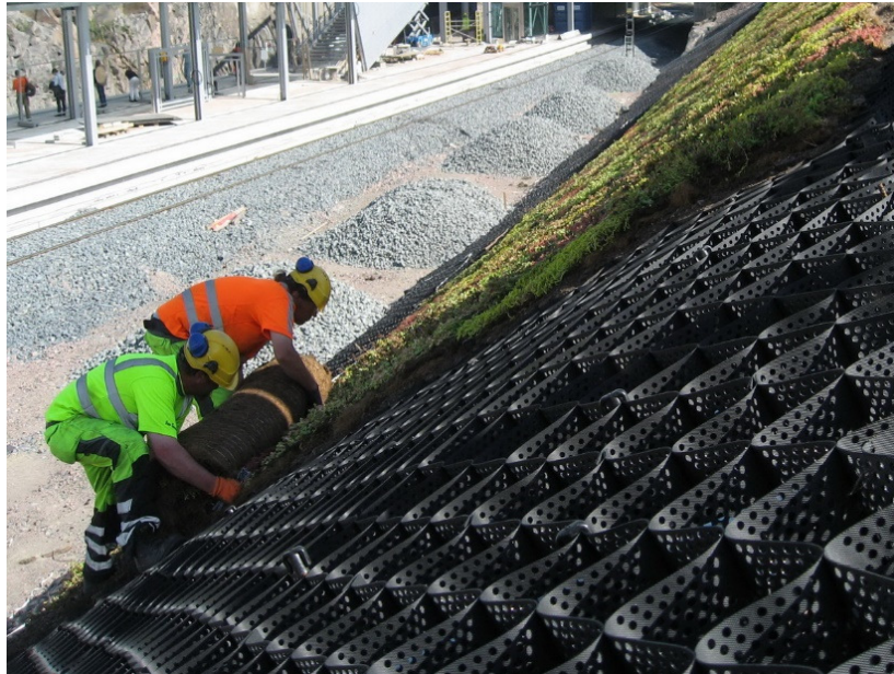
Slika 55. Primjer ozelenjavanja lica zida ( https://www.green-tech.co.uk )
