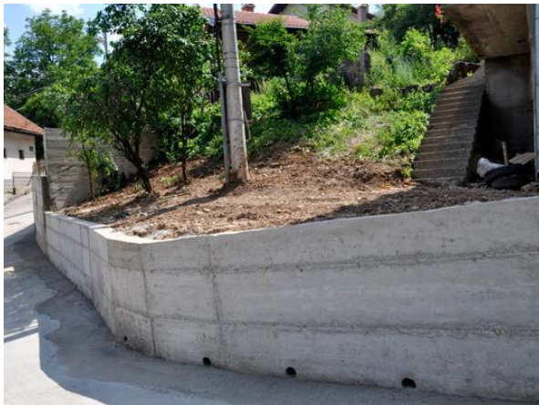
Slika 8: Armirano-betonski potporni zid [2]
