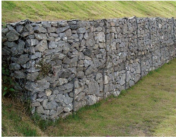
Slika 12: Zid od nasutog materijala ojačan čeličnim kavezom (gabion) [13]
