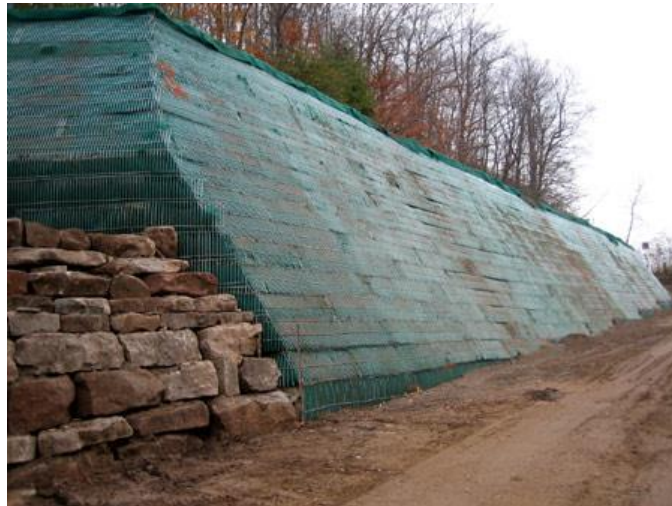
Slika 13: Zid od nasutog materijala ojačan geomrežom [13]
