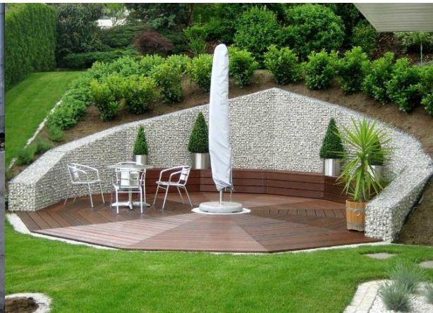
Slika 9: Gabionski potporni zid [10]
