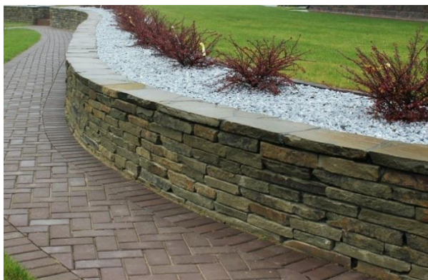
Slika 14 : Zidovi od lomljenog kamena [13]
