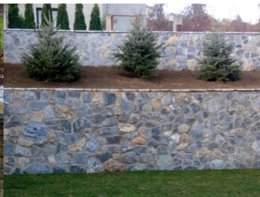
Slika 15: Zid od klesanog kamena [13]
