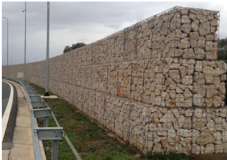
Slika 28: Gabionski potporni zid [17]
