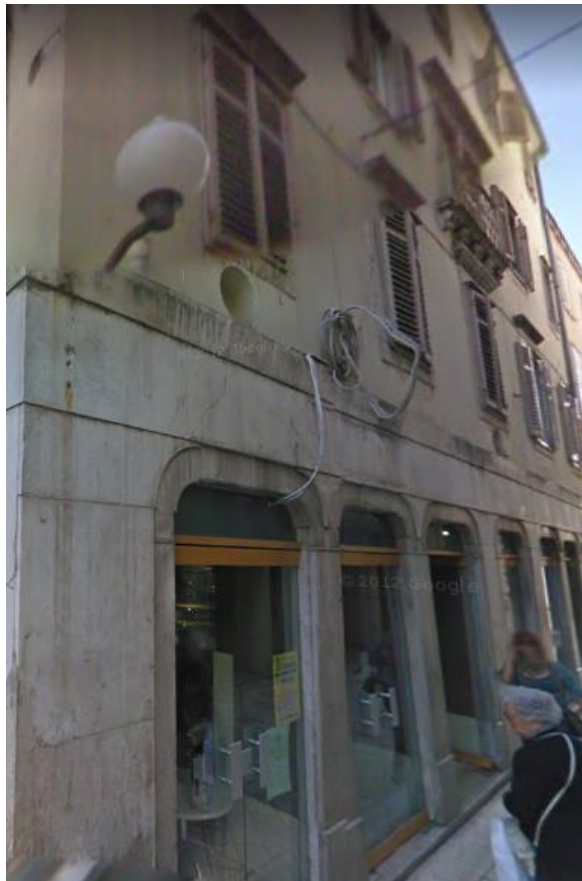
Slika 35: Pogled na zgradu u ulici braće Vranjanina 9/1 [19]
