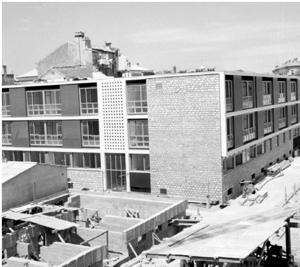
Slika 18: Pogled na zgradu ZB III u vrijeme završetka radova [21]
