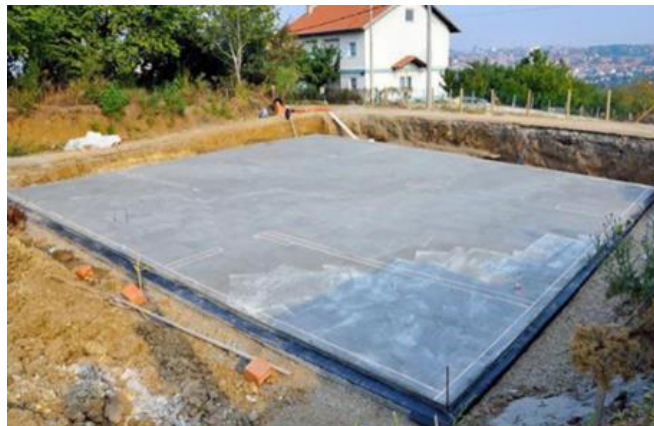
Slika 59: Horizontalna hidroizolacija [13]
