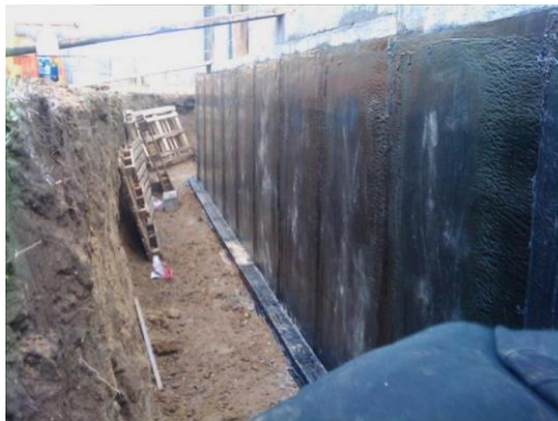
Slika 58: Vertikalna hidroizolacija [13]
