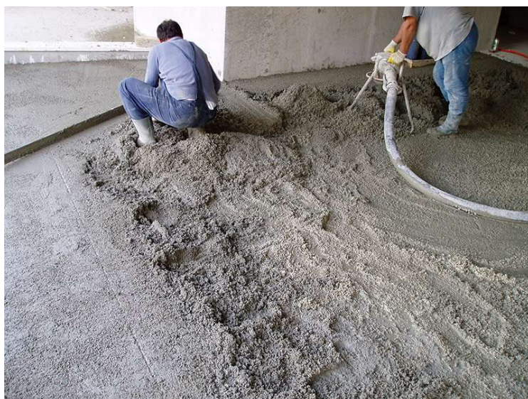
Slika 4: Izrada plivajućeg poda od EPS betona [8]
