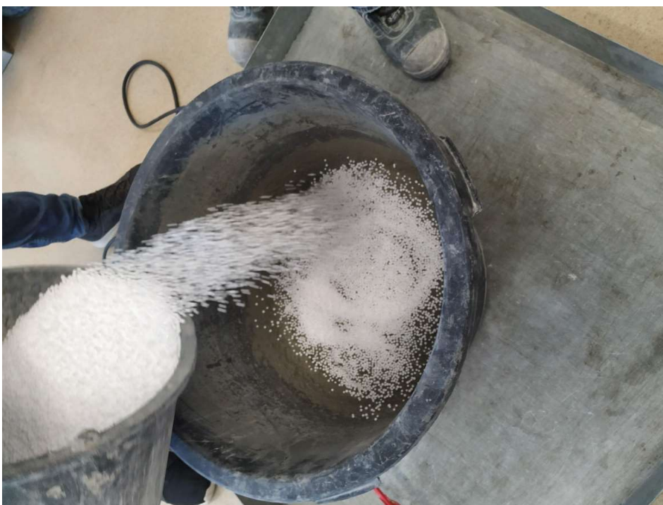
Slika 8: Dodavanje EPS granula u beton
