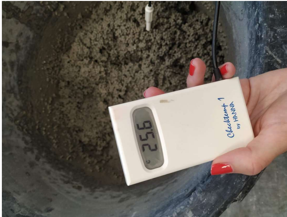
Slika 11: Mjerenje temperature smjese probne mješavine
