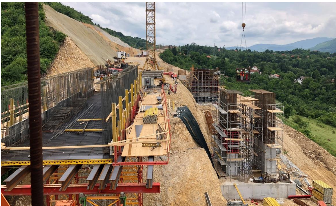
Slika 5: Dio izvedenog upornjaka U1L i U1D (autor: Patricia Blažević)
