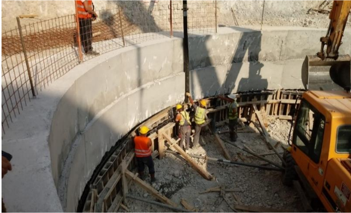
Slika 7: Armirano betonski prsten (autor: Zoran Jelovac)
