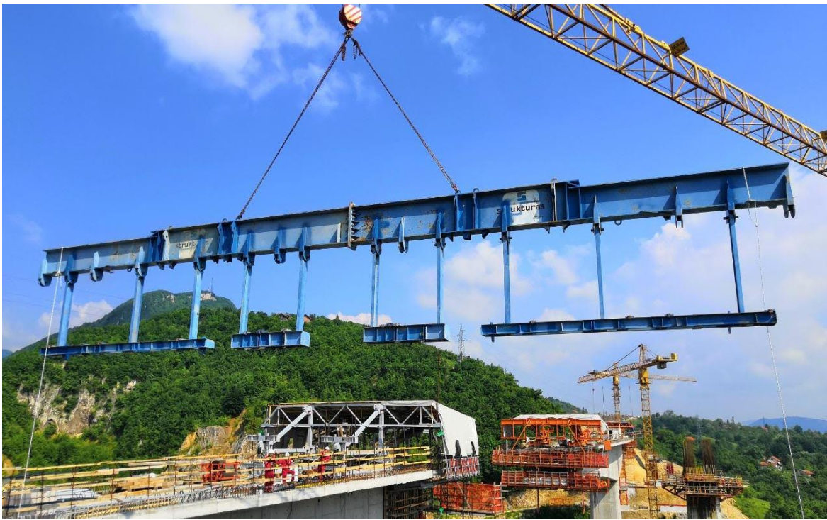
Slika 31: Podizanje elemenata krlatke (autor: Kenan Zaimović)
