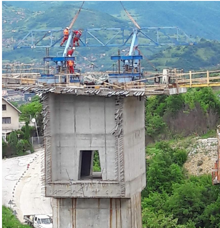
Slika 16: Nulti segment rasponske konstrukcije (autor: Kenan Zaimović)
