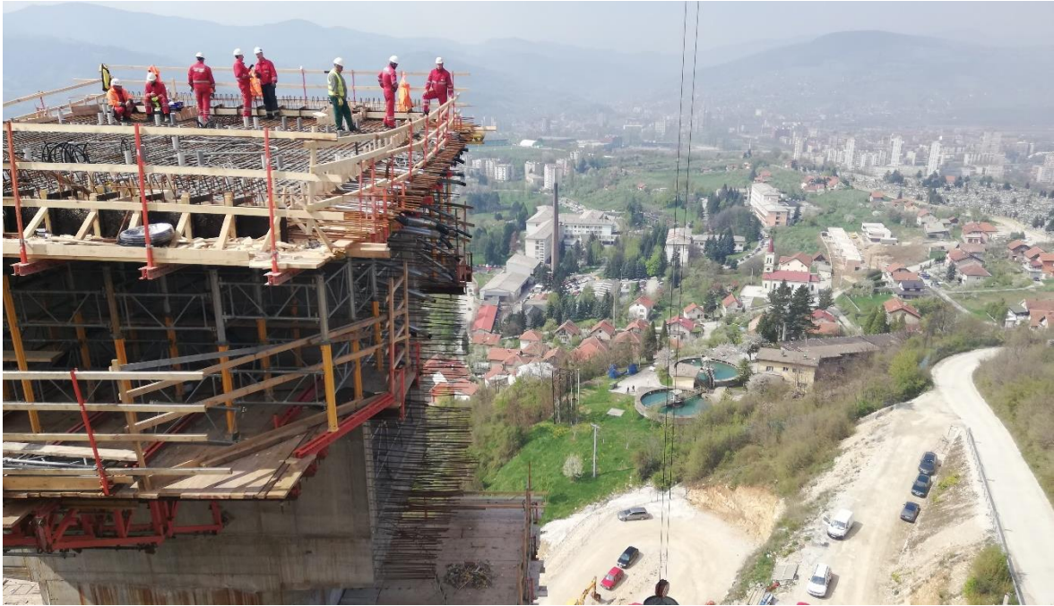
Slika 27: Ugradnja armature gornje ploče nultog segmenta rasponske konstrukcije (autor: Kenan Zaimović)
