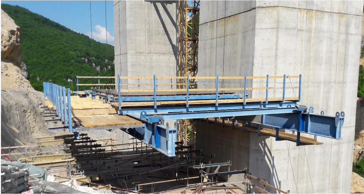
Slika 32: Podizanje oplata donje ploče (autor: Kenan Zaimović)
