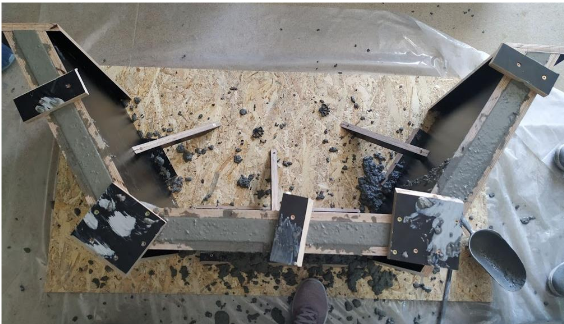
Slika 37: Ulijevanje betona u oplatu
