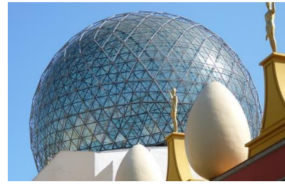
Slika 17: Primjer geodetske kupole (Designing Buildings Wiki 2018)
