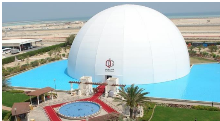
Slika 14: Prikaz napuhane kupole (Architen Landrell 219)
