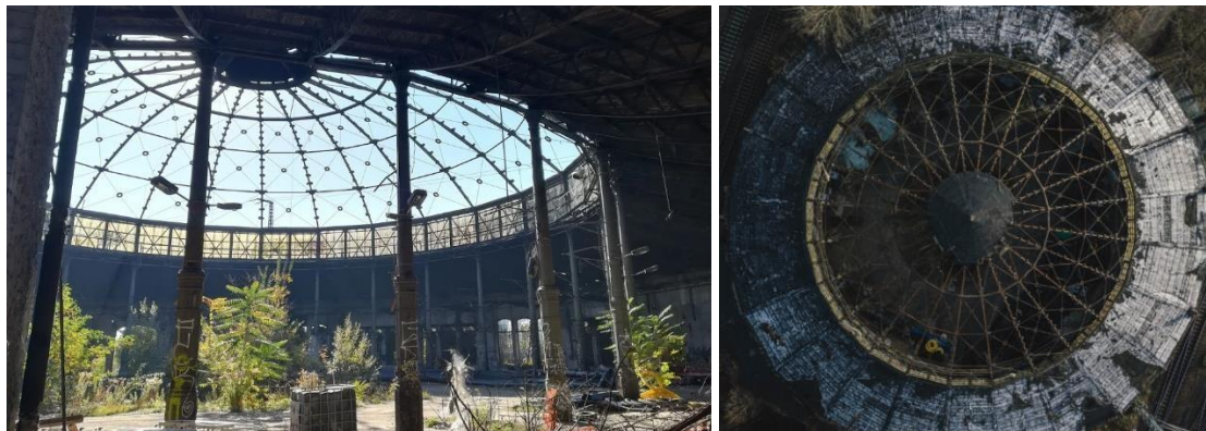
Slika 31: Rundlokschuppen Rummelsburg; unutrašnji (lijevo) i vanjski (desno) izgled kupole (The urbanite 2019)
