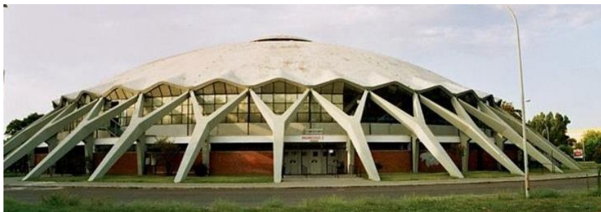
Slika 12: Prikaz predgotovljene kupole sportske dvorane u Rimu (Enciklopedija.hr)
