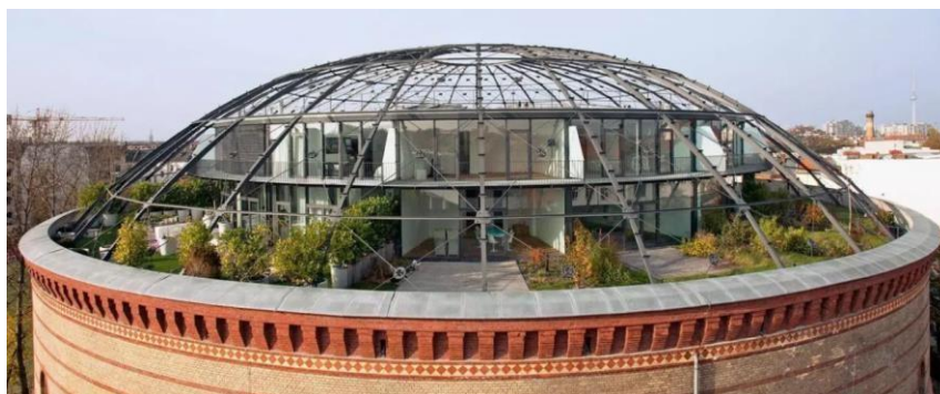
Slika 25: Izgled krova Fichte-Bunkera danas (I1.wp)
