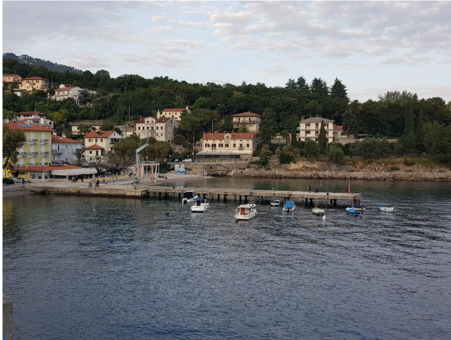
Slika 3: Postojeće stanje sekundarnog lukobrana (autor:Nina Čepić)
