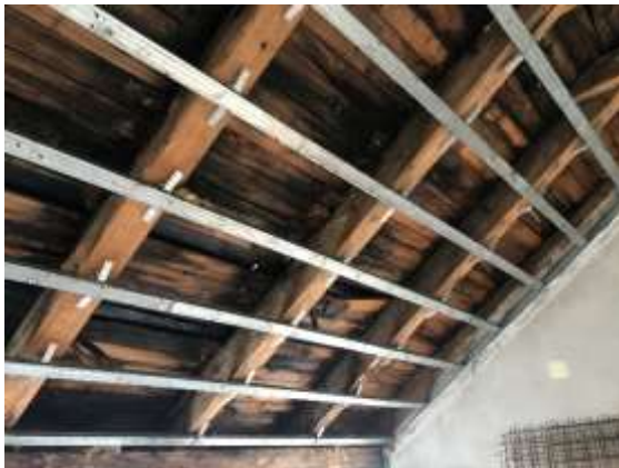
Slika 4.c: Modrina na daščanoj oplati i raspucalost
