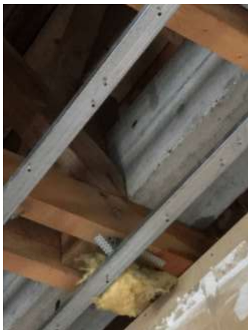
Slika 2: Spoj pajante i vertikalne kladice
