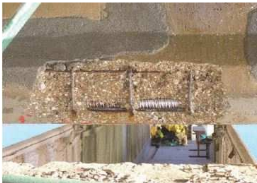
Slika 24. Izgled površine nakon uklanjanja oštećenog sloja betona [13]
