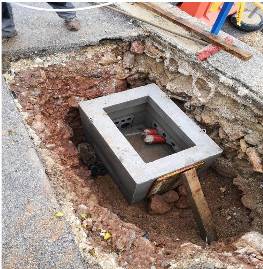
Slika 12: Ugradnja zdenca
