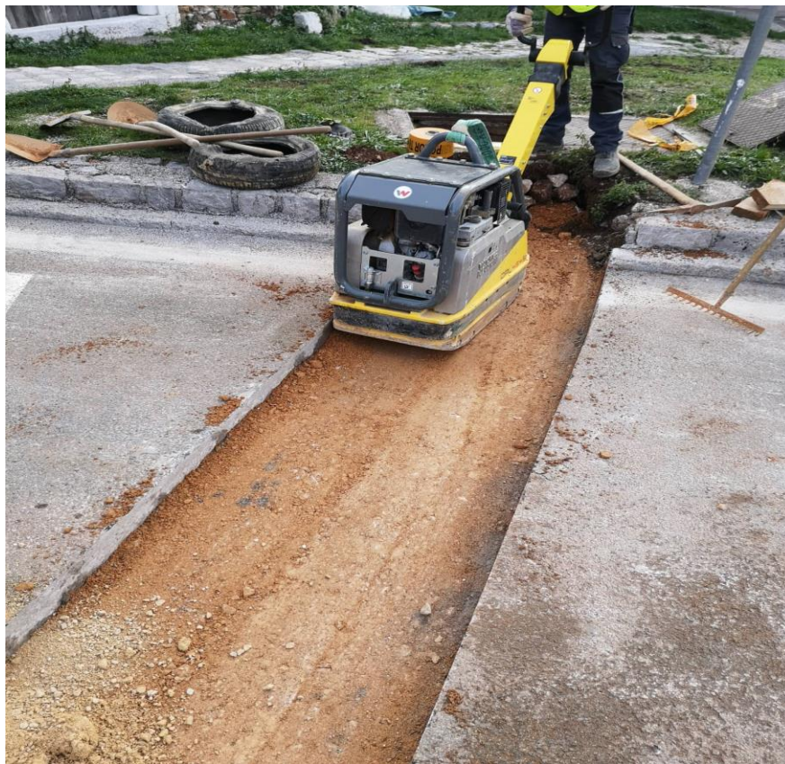
Slika 19: Ugradnja i nabijanje tamponskog sloja
