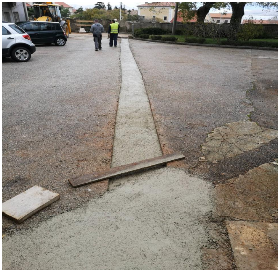
Slika 22: Izvedba betonske stabilizacije
