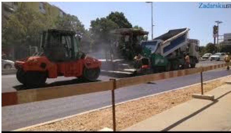
Slika 23: Ugradnja asfalta
