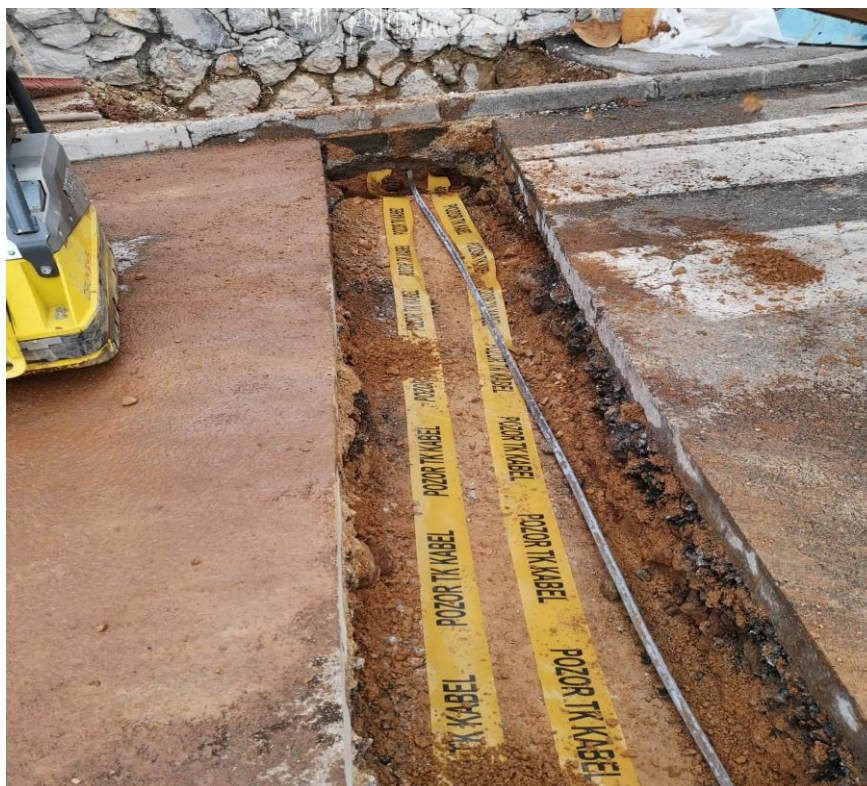
Slika 18: Zatrpavanje rova i postavljanje DTK zaštite
