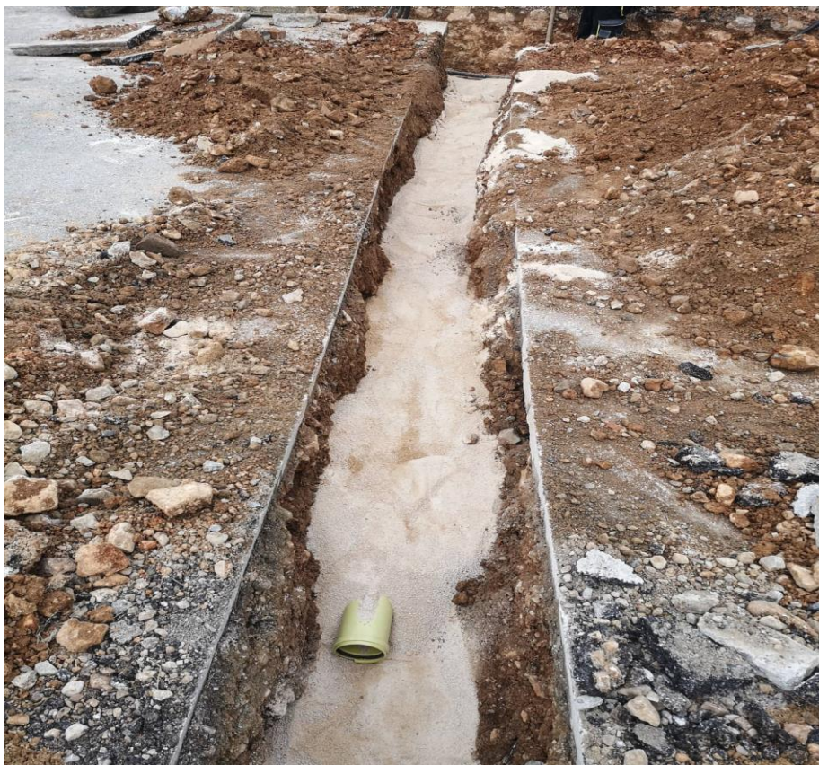
Slika 15: Zasipavanje položenih cijevi s pijeskom 0 – 4 mm
