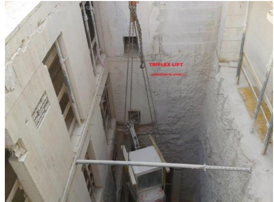
Slika 99. Završetak iskopa i izvlačenje stroja
