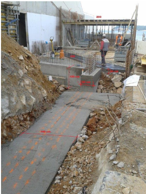
Slika 114. Betoniranje stepenastih soba, 2013.
