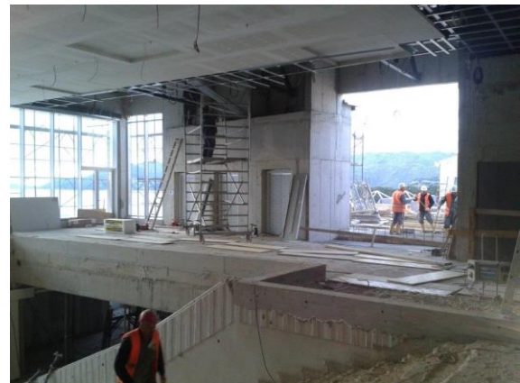
Slika 104. Završetak betoniranja okna dizala etaže 7, 2014.
