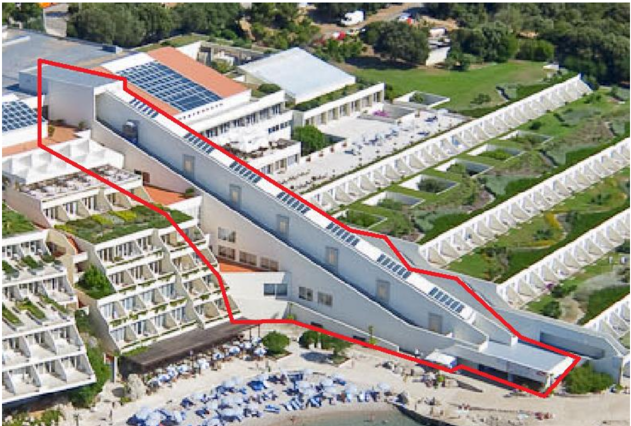
Slika 110. Postojeće stanje kosih dizala
