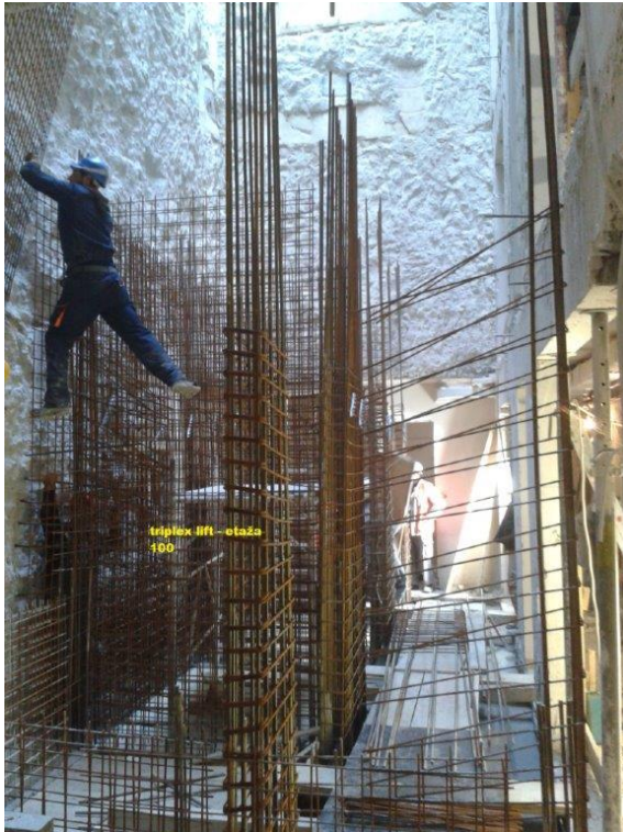
Slika 101. Armiranje okna dizala, 2013.
