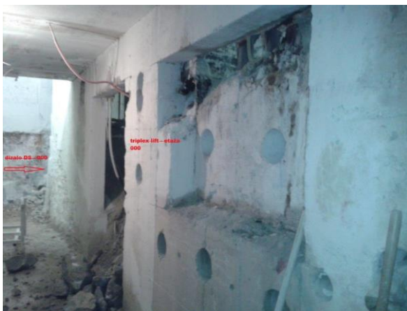
Slika 98. Iskop okna dizala u betonskom temelju, 2013.
