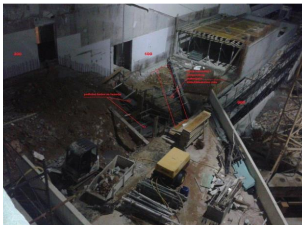
Slika 117. Betoniranje stepenastih soba, 2013.
