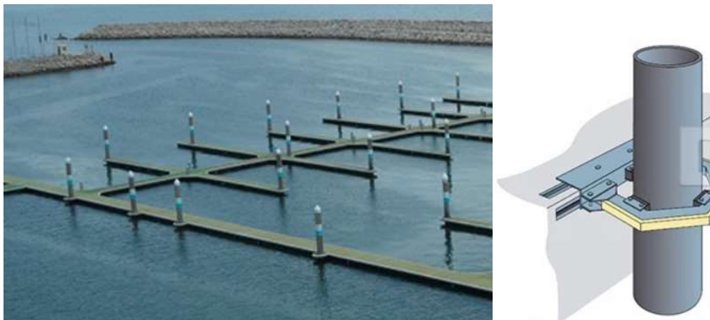
Slika 35. Sidrenje pontona stupovima [35]
