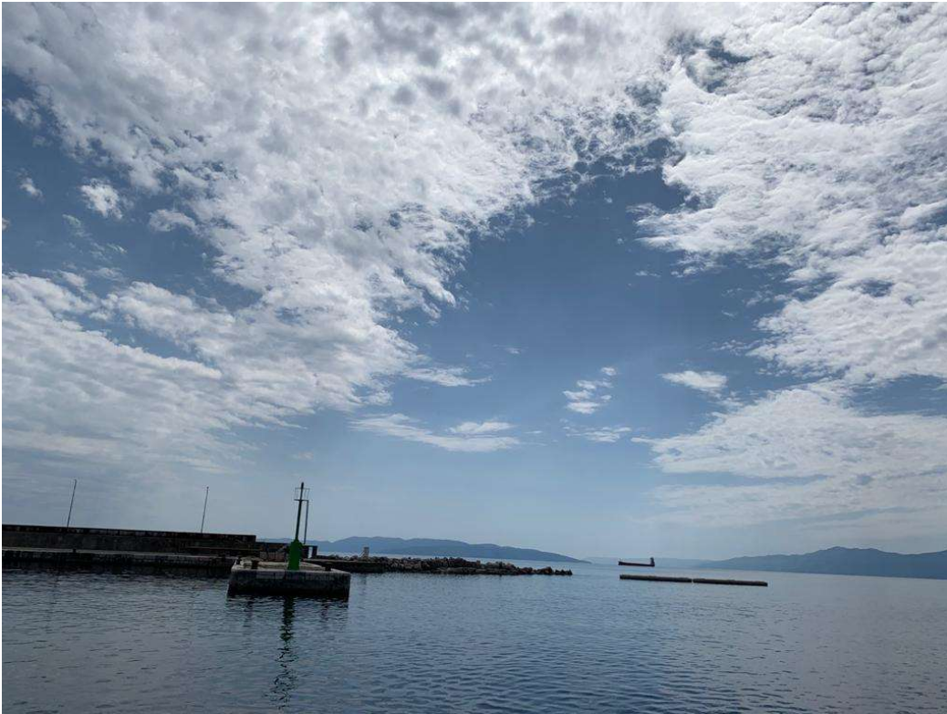
Slika 47. Pogled na neizgrađeni dio Sušačkog lukobrana
