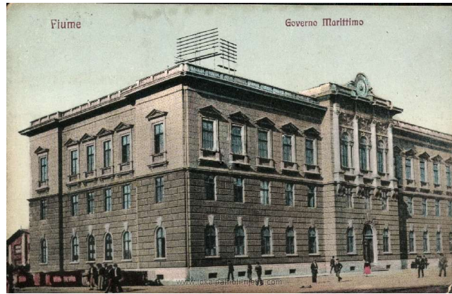
Slika 11. Zgrada lučke uprave iz 1885. godine [8]
