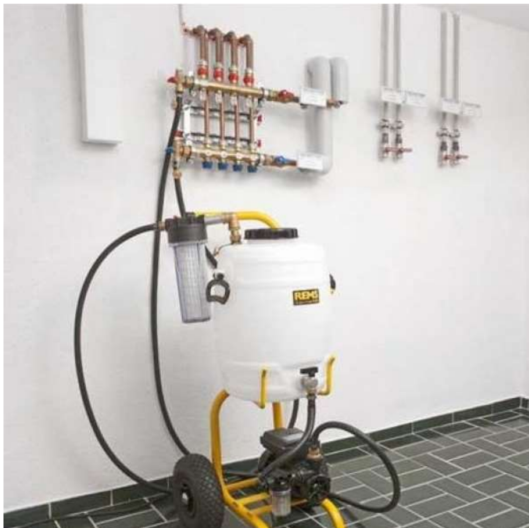
Slika 4. Ispitivanje vodovoda tlačnom pumpom
