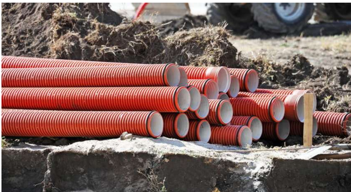
Slika 14. Cijevi za vanjsku kanalizaciju
