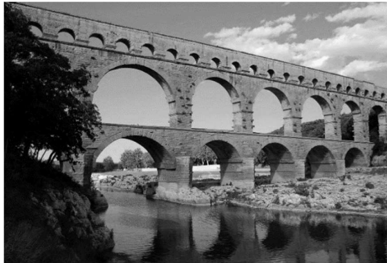
Abbildung 2.2: Pont du Gard, Nîmes, Frankreich [3]
