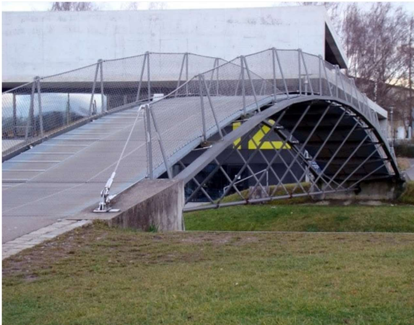
Abbildung 3.5: Fußgängerbrücke über den Allmandring, Stuttgart [45]
