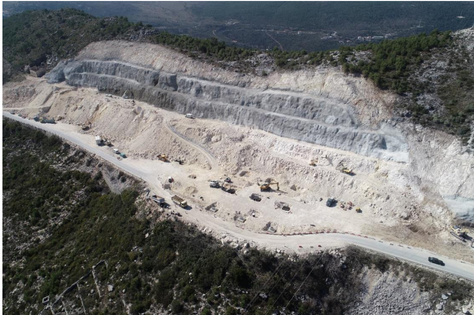
Slika 53 Pogled na izvedbu osiguranja pokosa zasjeka (Foto: V. Damjanović)
