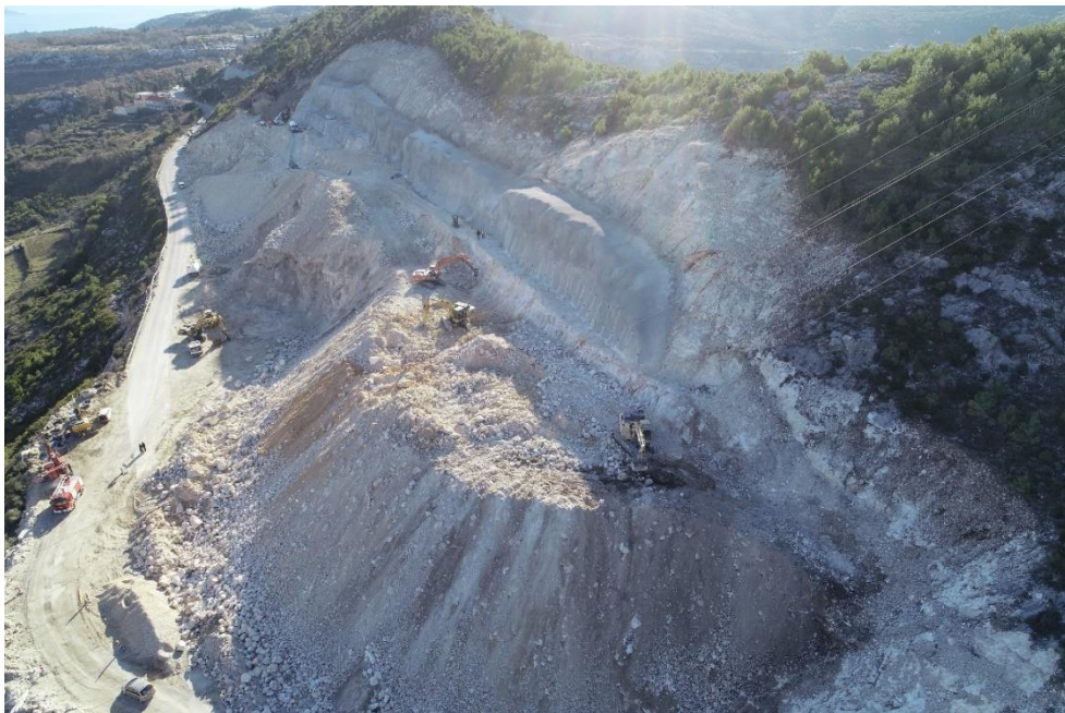
Slika 52 Pogled na izvedenu prvu i drugu vertikalnu radnu etažu (Foto: V. Damjanović)
