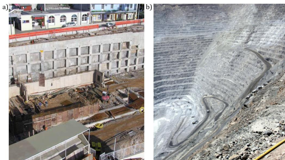
Slika 7 a) Pogled na izvedenu konstrukciju na građevnoj jami Kantrida u Rijeci [Arbanas et al., 2007] (Foto: T. Pap); b) Rudnik Chuquicamata u obliku otvorenog kopa, sjeverni Čile (Hoek and Brown, 2018)
