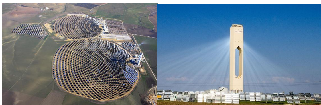
Slika 10: Solarni toranj, Sevilla (Španjolska) (izvor: https://eko.zagreb.hr/fokusiranje-sunceve-energije/88 , 2020)
