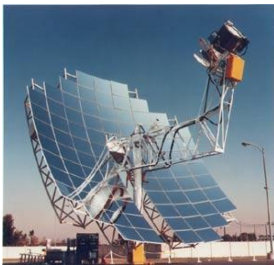
Slika 7: Solarni parabolički tanjur (izvor: https://eko.zagreb.hr/fokusiranje-sunceve-energije/88 , 2020)
