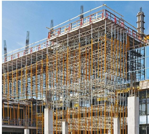
Slika 6. Primjena MULTIPROP tornja za podupiranje [3]
