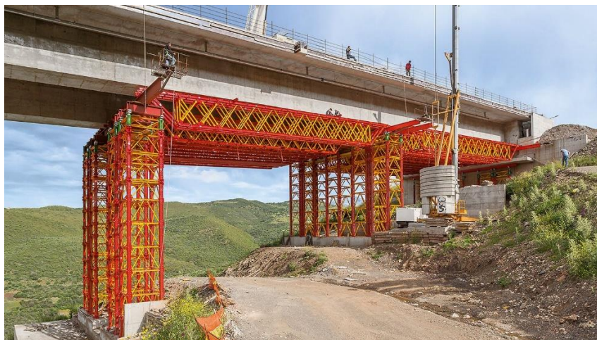
Slika 7. Kombinacija konzolnih spojnih elemenata i tornjeva za teška opterećenja [3]
