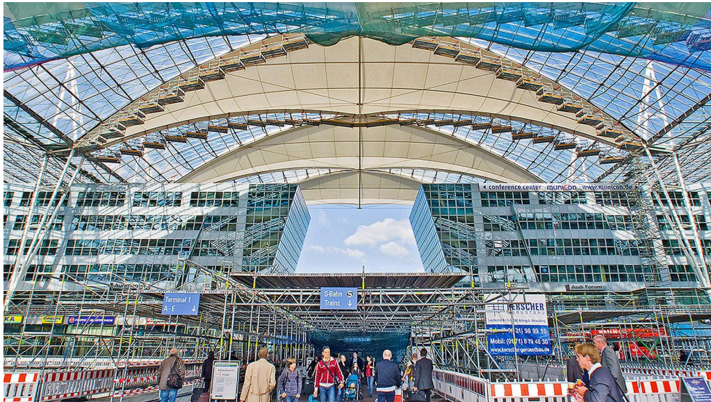
Slika 11. Sanacija forumskog krova zračne luke u Munchenu [3]
