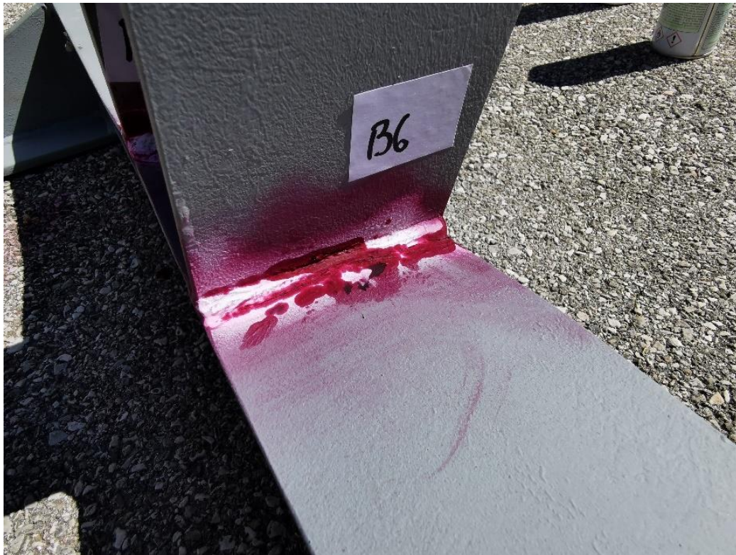
Slika 41: Velika pukotina na zavaru B6 (Izradio autor)
